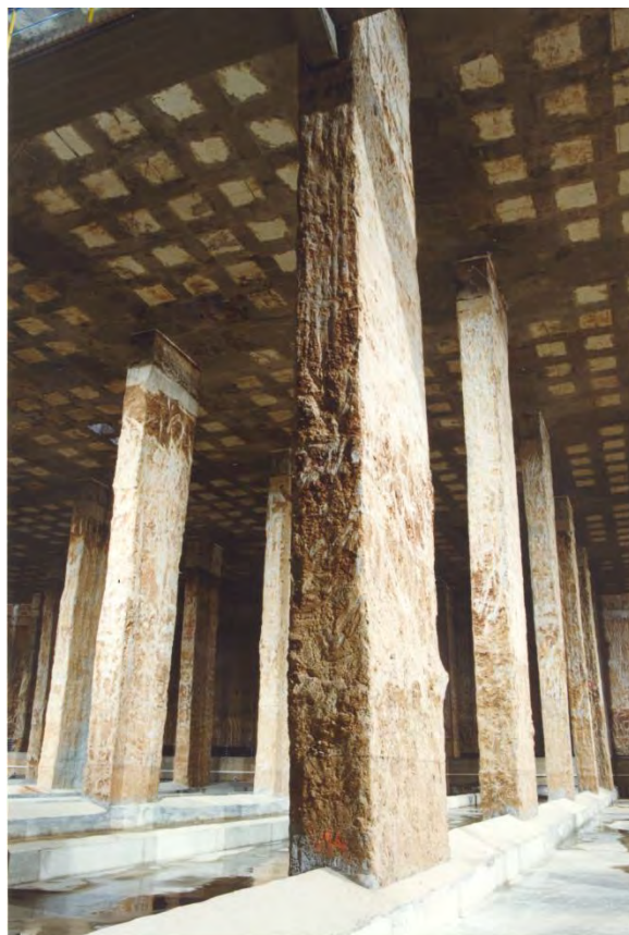
Figura 61 Tanque de Bori Fontestà en Barcelona donde se pueden observar los carriles de limpieza.
