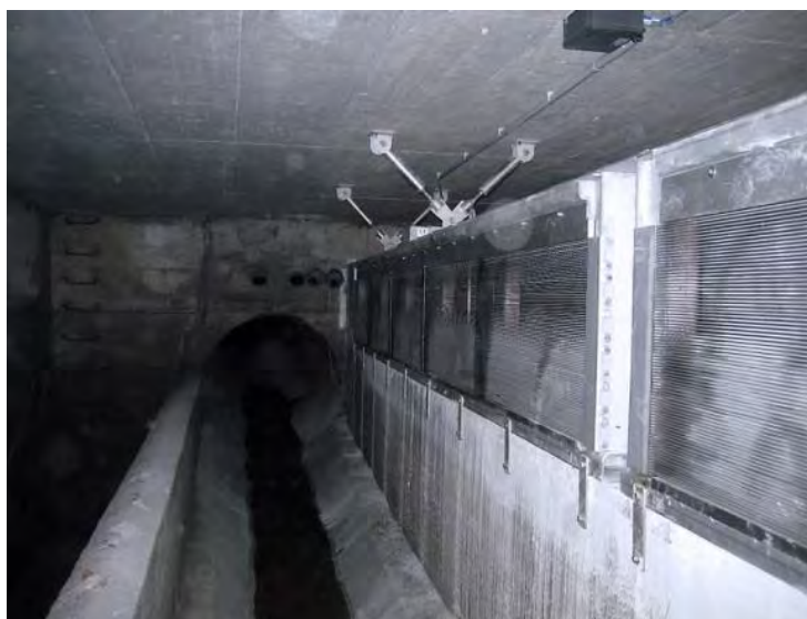
Figura 29 Ejemplo de reja de tamiz de barras
