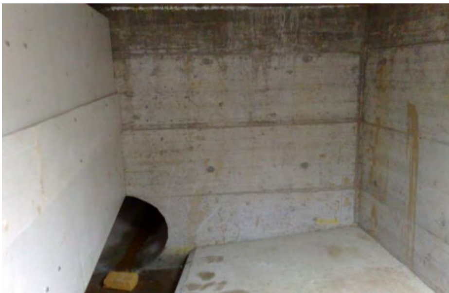
Figura 25 Ejemplo de pantalla mal diseñada.
