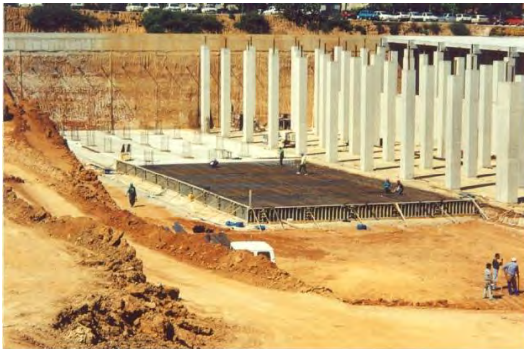
Figura 72 Ejecución de solera y pilares
