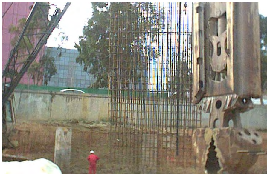
Figura 71 Ejemplo de construcción de cerramiento lateral mediante pantalla continua y colocación de sus armaduras
