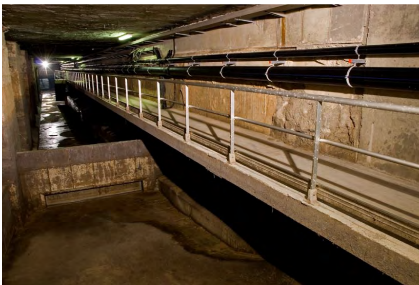
Figura 76 Ejemplo de pasarela con barandilla de seguridad en el tanque de Taulat (Barcelona).
