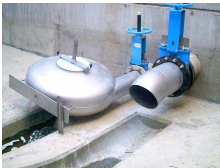
Figura 19 Válvula tipo vórtice
