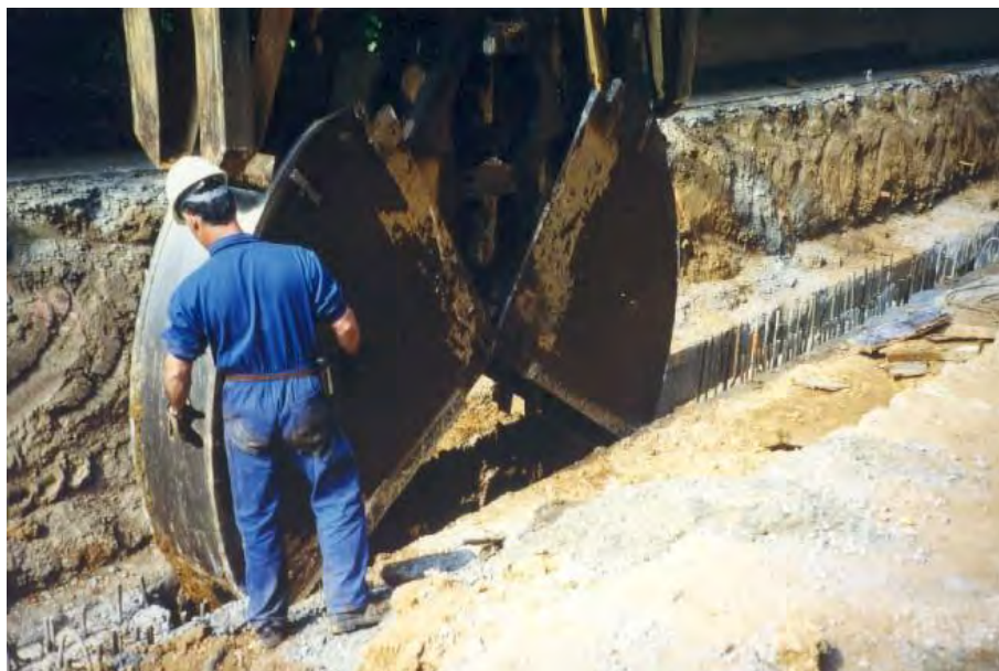
Figura 64 Ejecución de muro continuo.
