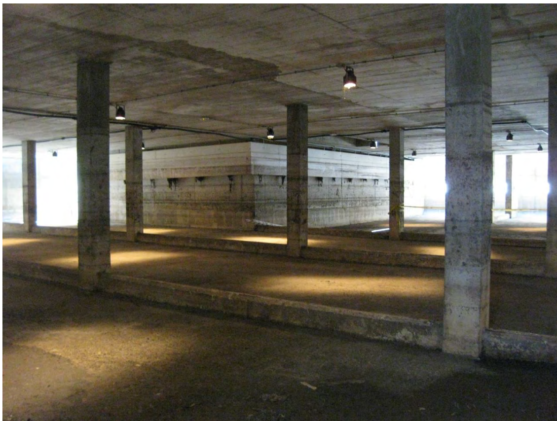
Figura 1 Ejemplo de tanque de tormentas de Cantarranas (Madrid)
