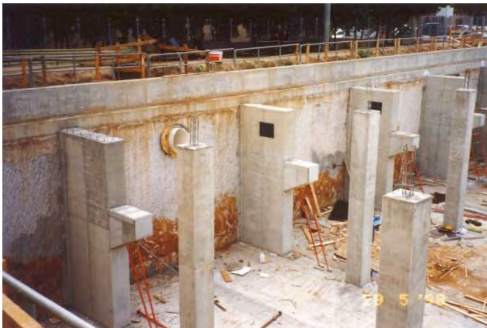
Figura 73 Ejecución de cimentación y pilares
