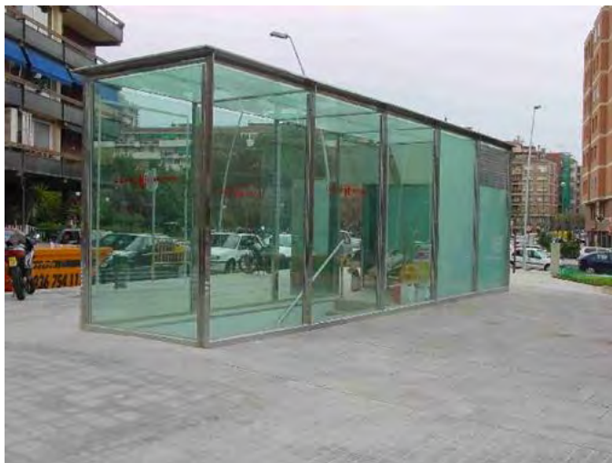
Figura 87 Edículo de entrada a unos locales técnicos enterrados
