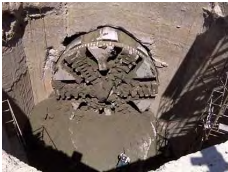
Figura 38 Construcción de túnel anti-DSU de 5 m de diámetro y 3.2 Km de longitud en Boston (EEUU)
