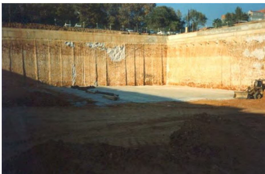
Figura 65 Excavación entre pantallas.
