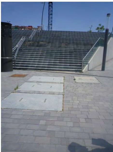
Figura 57 Tapas de extracción de bombas en un tanque
