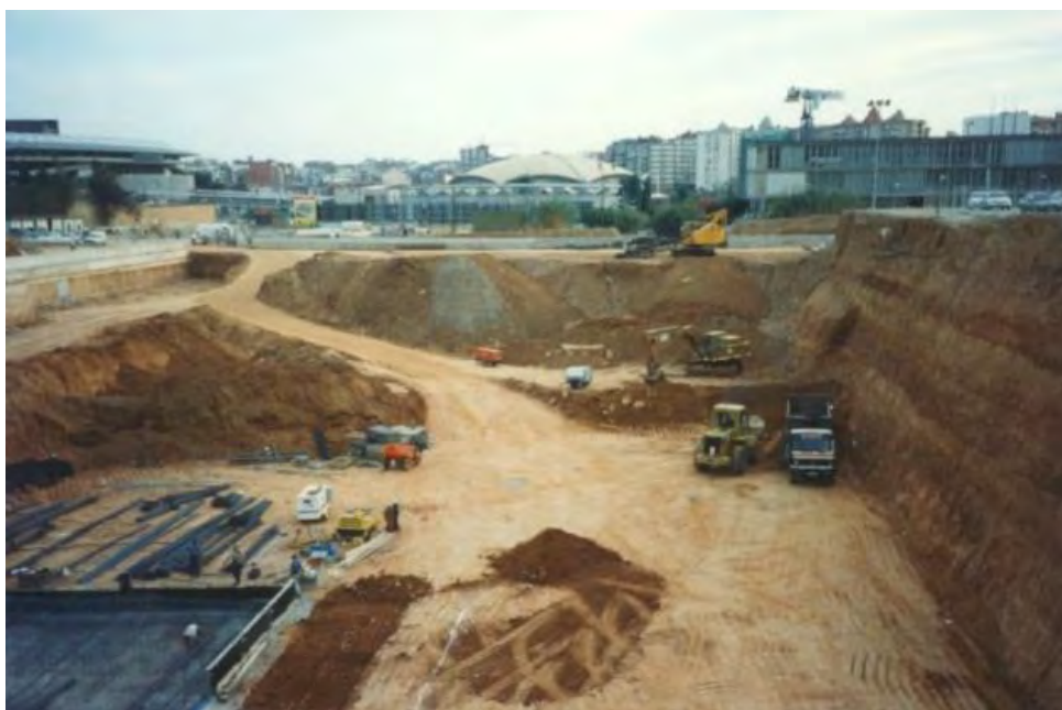
Figura 63 Excavación en talud
