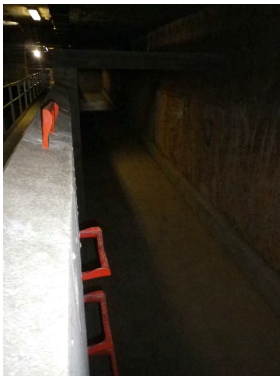
Figura 39 Aliviadero de emergencia. Depósito de Drs Dolsa (Barcelona)
