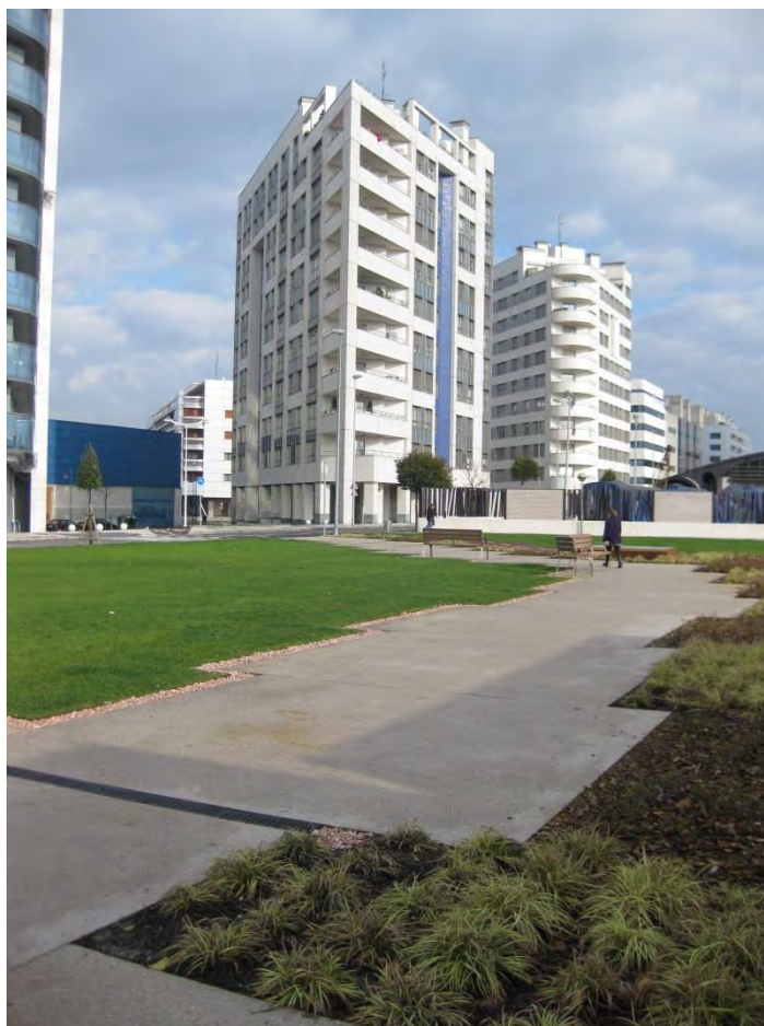
Figura 56 Urbanización en superficie de tanque en Gijón
