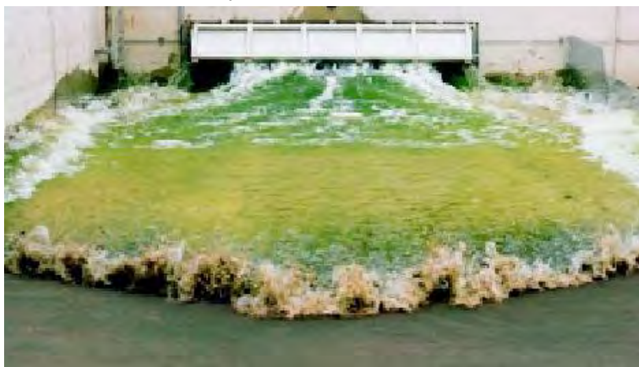
Figura 47 Operación de limpieza mediante la apertura de la clapeta de descarga
