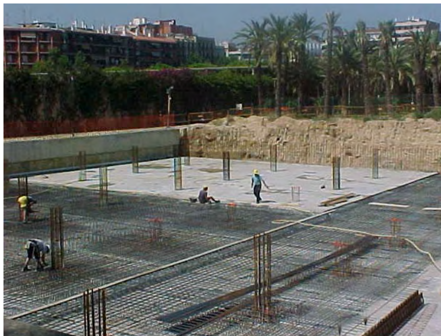
Figura 67 Construcción invertida de tanques. Ejecución de losa empotrada entre pilares y sobre el terreno.
