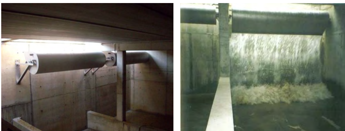
Figura 44 Limpiador basculante en reposo y en acción
