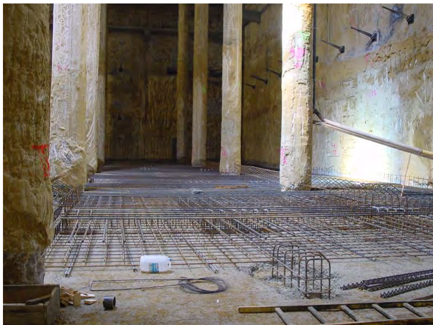
Figura 69 Construcción invertida de tanques. Ejecución de la solera.
