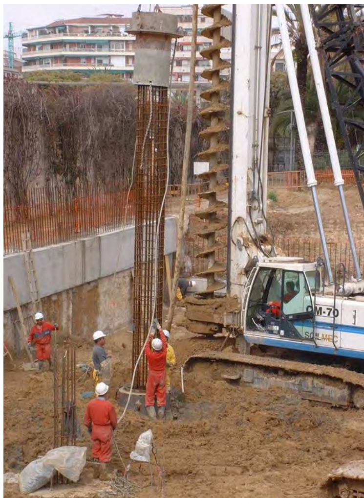
Figura 66 Construcción invertida de tanques. Ejecución de pilares mediante pilotes.
