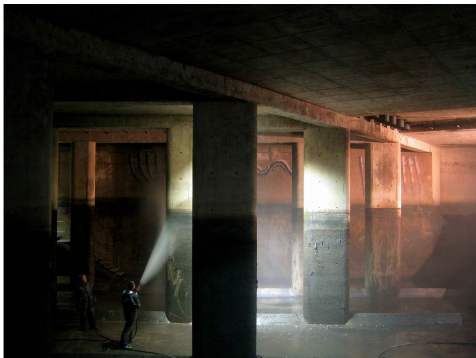
Figura 60 Limpieza manual de tanque en Gijón
