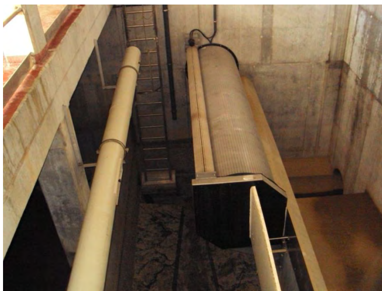
Figura 30 Rototamiz automático
