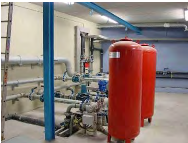
Figura 82 Circuito de agua a presión
