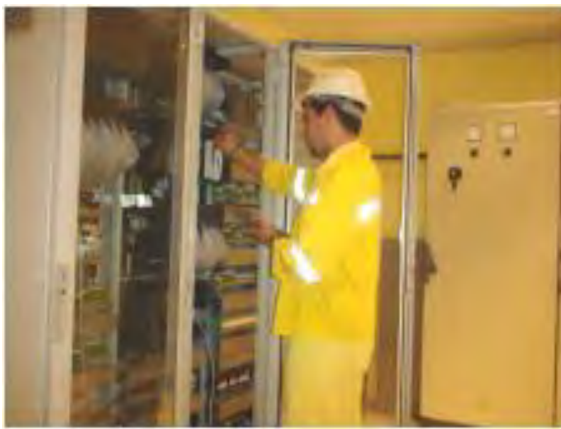
Figura 92 Operación de mantenimiento preventivo en cuadros de control de un tanque.
