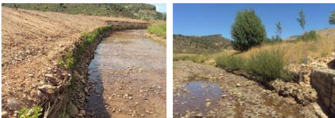
Figura 6.16 Empalizada trenzada y gabión flexible y muro krainer al fondo. Río Linares en Riba de Saélices (Guadalajara). Intervención recientemente finalizada (sup.) y evolución un año después (inf.)
