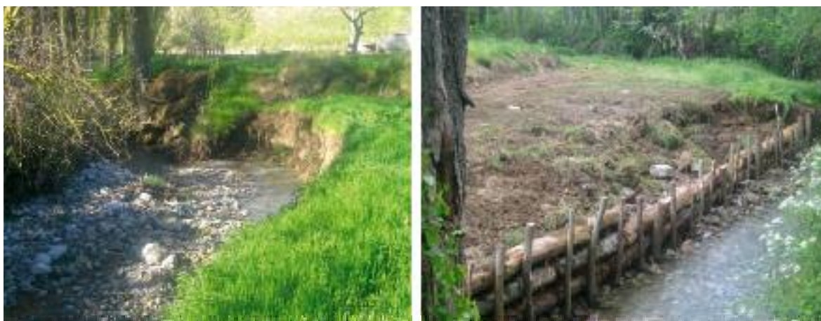
Figura 3.7 Estabilización de taludes mediante la aplicación de técnicas de bioingeniería en Arcos de las Salinas (CH Júcar): antes del comienzo de las obras y durante su realización
