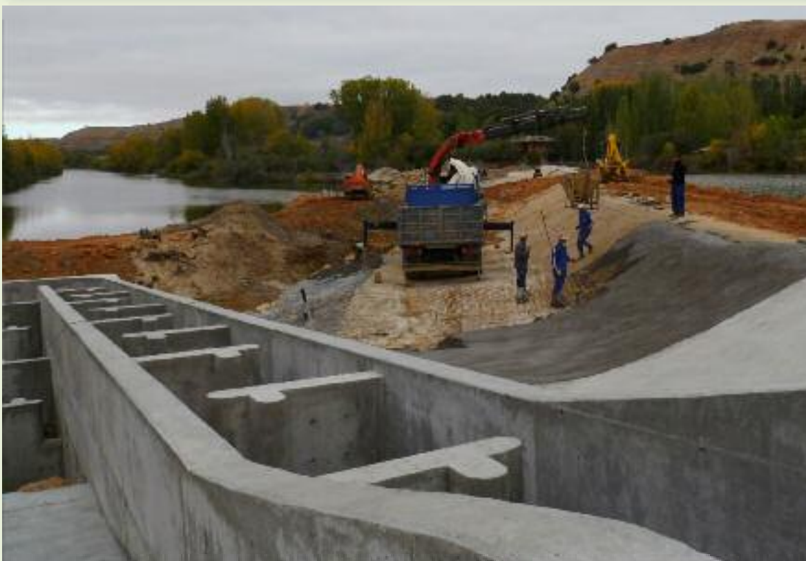
Figura 3.11 Escala de peces en la Central de la Flecha, río Tormes. Salamanca
