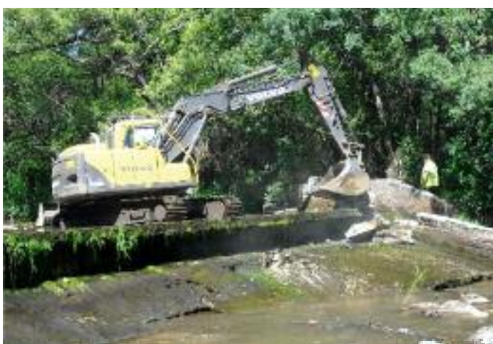
Figura 4.7 Demolición azud Pinilla. CH Tajo
