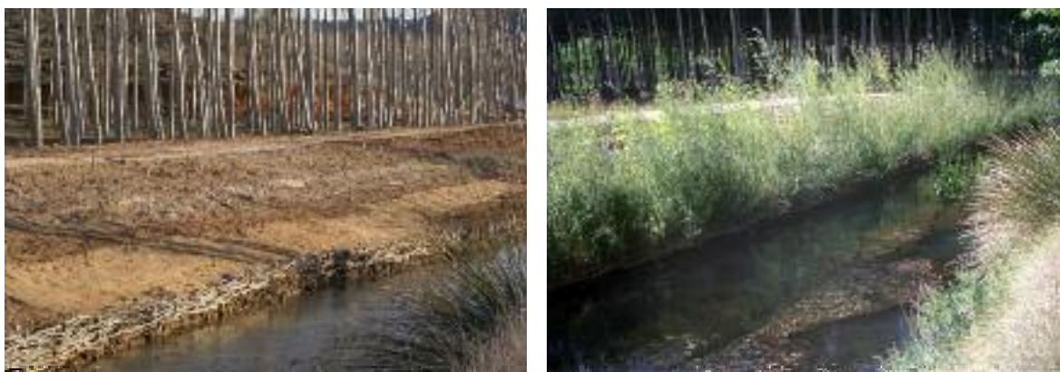
Figura 6.15 Empalizada trenzada, manta orgánica, estaquillado y plantación en el río Piedra en Llumes (Zaragoza) recién ejecutados (sup.) los trabajos y tras un año (inf.)
