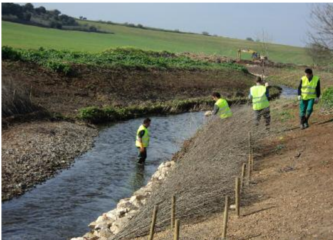
Figura 6.20 Disposición de lecho de ramas vivas para el fomento de la competencia con A. donax
