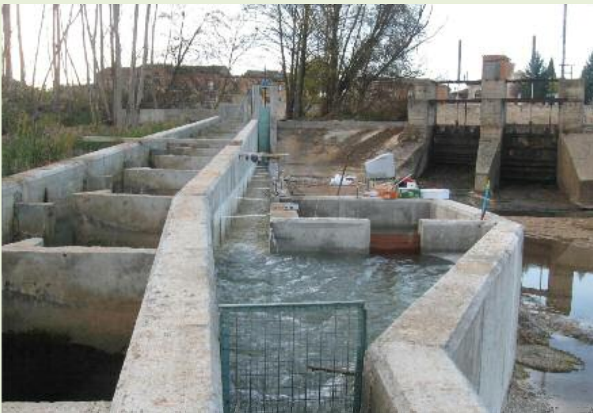
Figura 3.10 Canal de natación de peces en la Central de Vadocondes, río Duero
