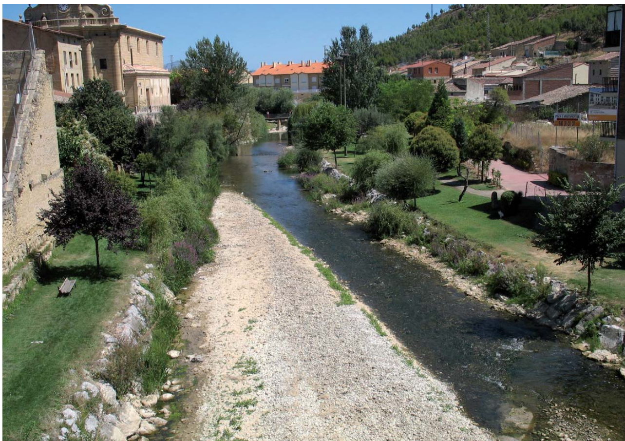
Parque fluvial y defensas laterales en el río Tirón.
