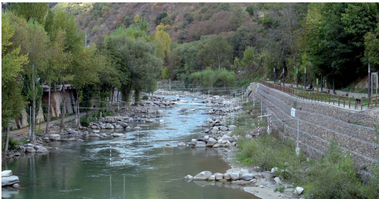
Modificación del cauce del río para aprovechamiento deportivo. Noguera Pallaresa en Sort.
