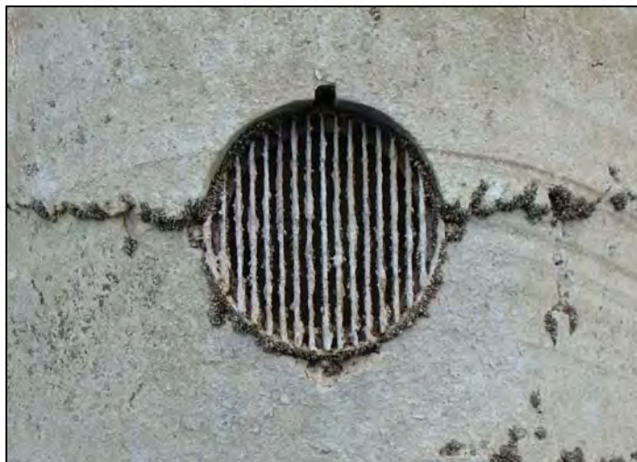
Figura 1. Imagen una toma de agua del embalse de Sichar, colonizada por organismos adultos de mejillón cebra, que podrían llegar a obturar la toma
