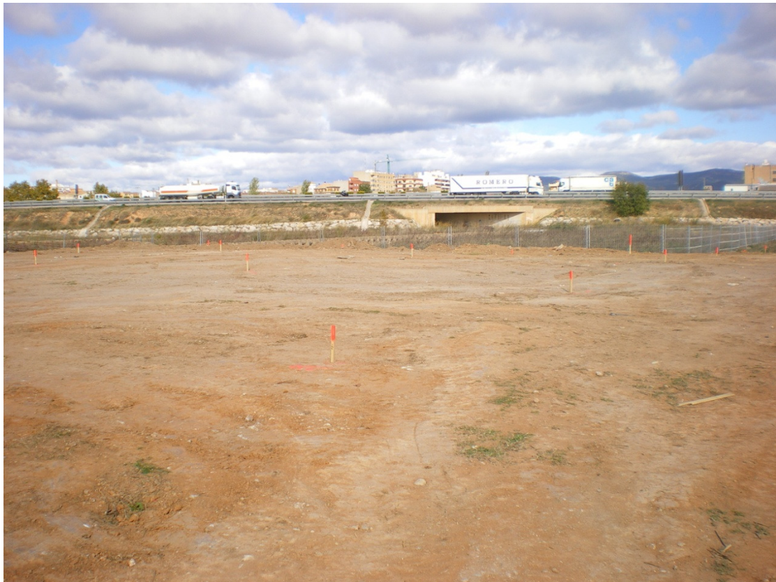
Estado de la obra en zona lúdico-didáctica.
