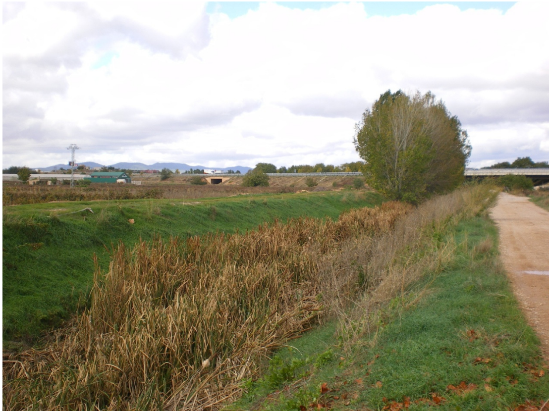
Estado del cauce y sus riberas
