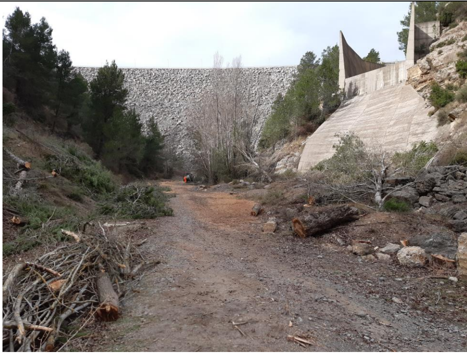
Zona de vertido actual
