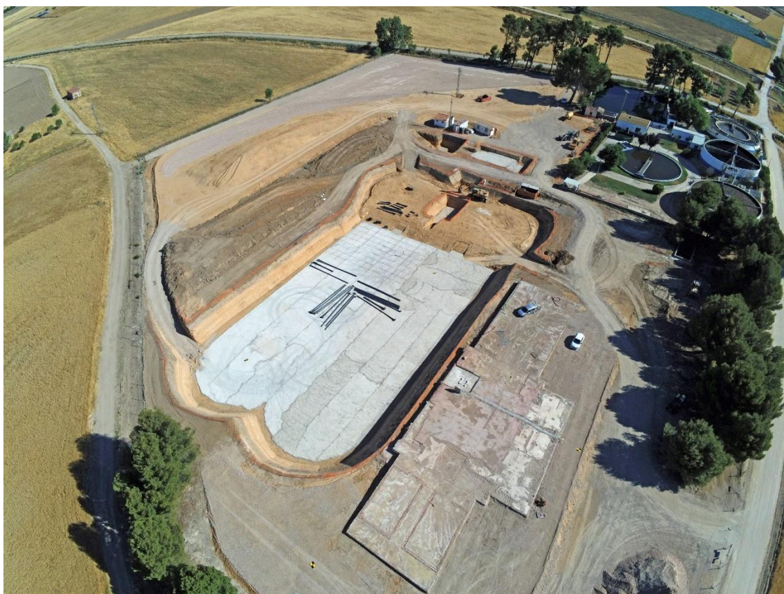
Planta General, una vez completadas las excavaciones y terraplenados. En la esquina superior derecha se observa la EDAR actual
