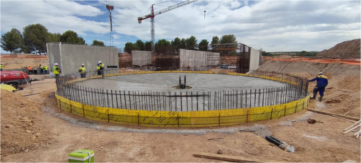
Obra civil en curso de decantadores secundarios
