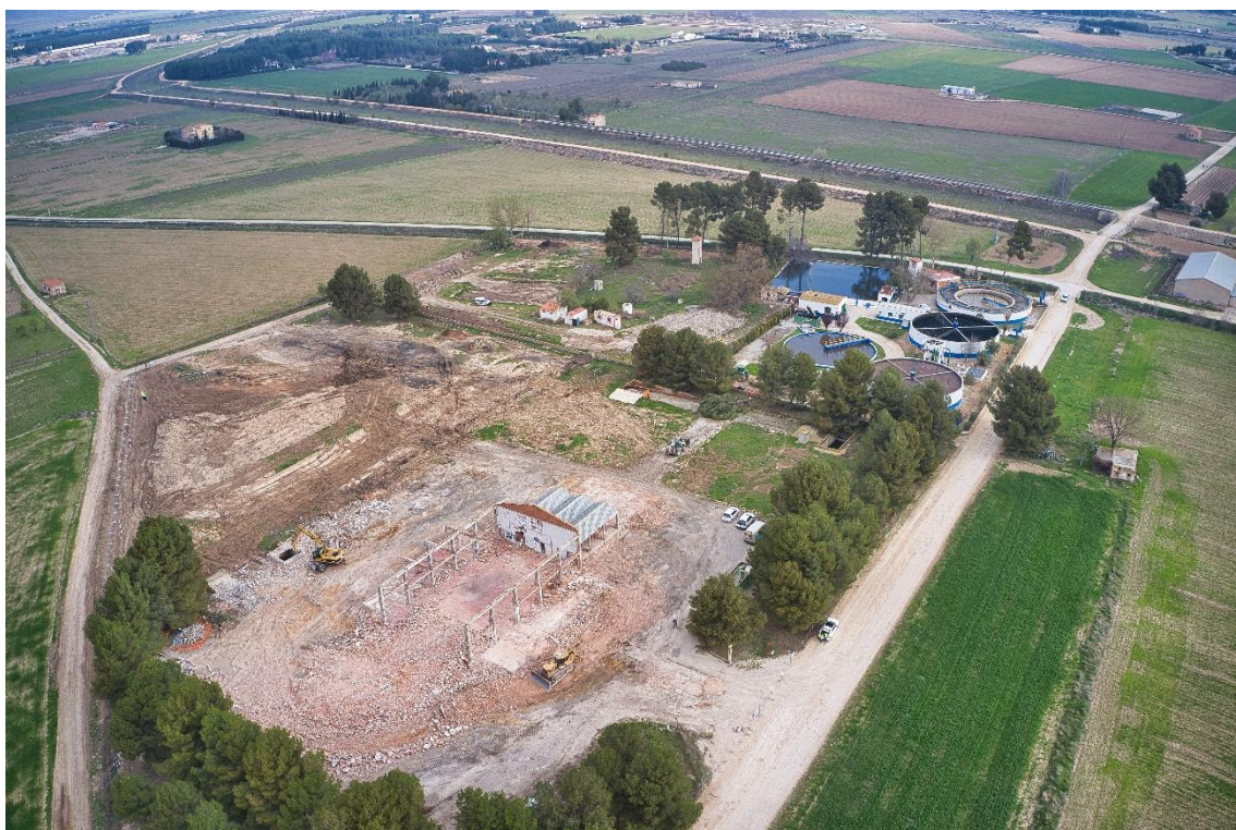
Aspecto de la parcela tras el inicio de los trabajos de demoliciones previas
