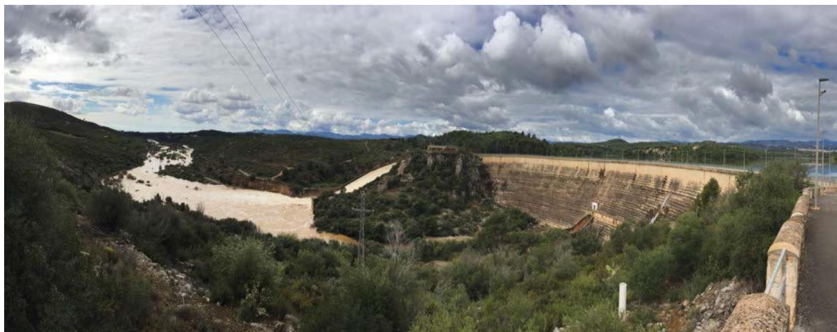
Vista general con aliviadero en carga
