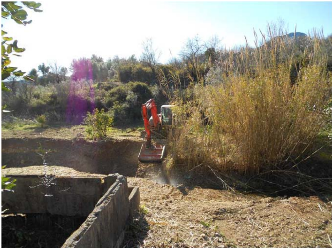
Astillado del cañar con medios mecánicos.
