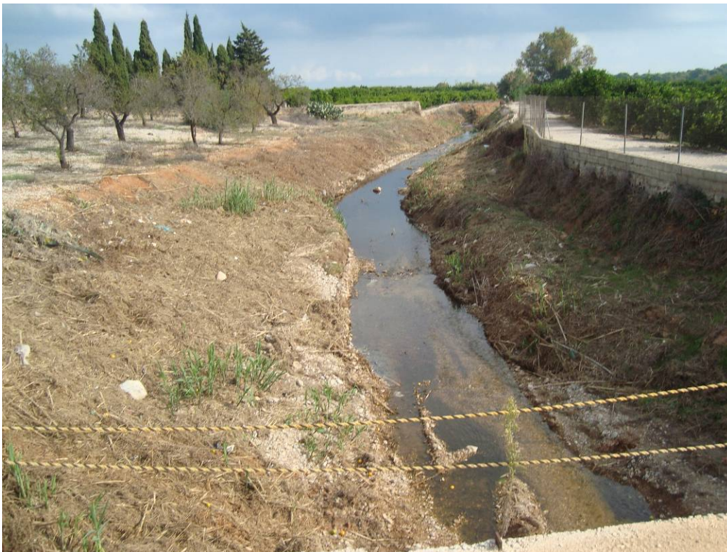
Vista del estado del cañar en el mismo tramo de cauce, tras la actuación.
