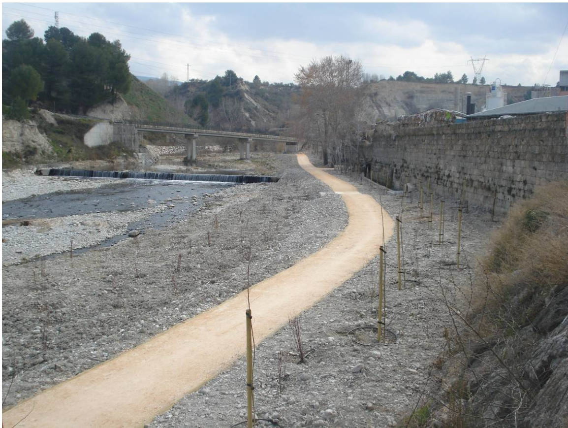
Aspecto del mismo punto del río tras los trabajos.
