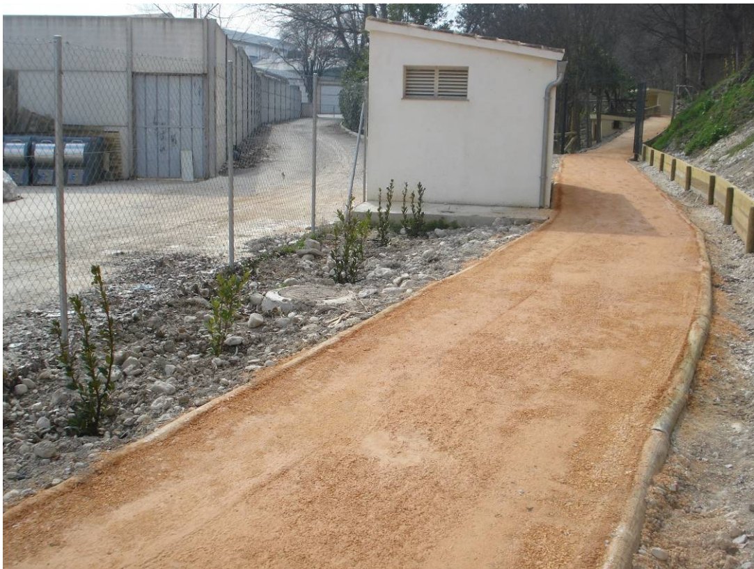
Aspecto del mismo punto tras los trabajos.
