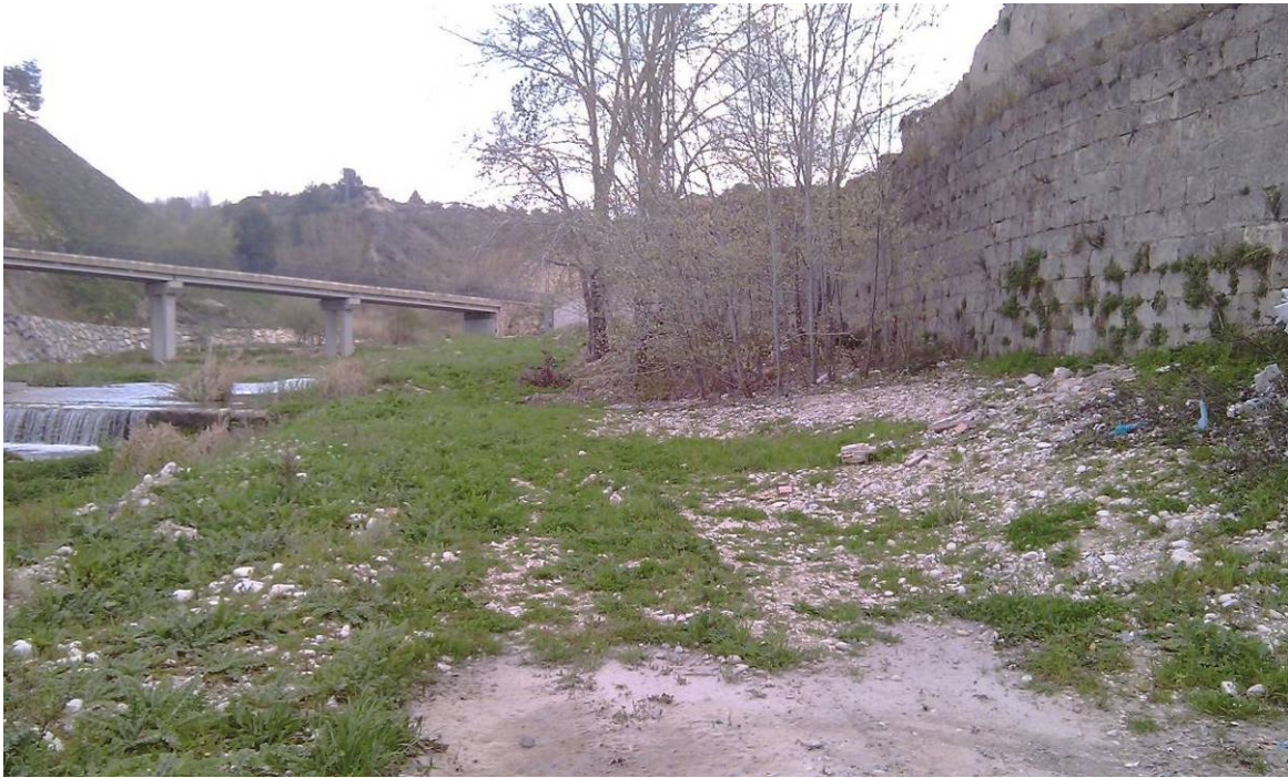
Aspecto del río junto al muro de la industria papelera antes de los trabajos.
