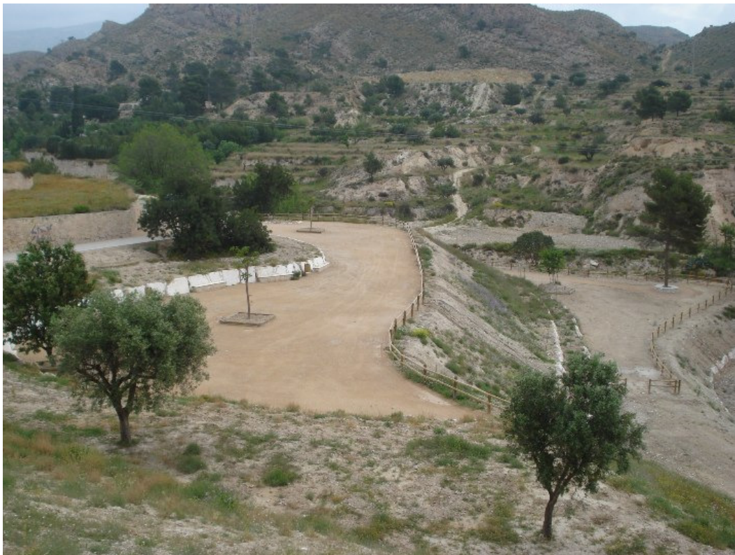
Estado del mismo tramo del barranco con los trabajos ya avanzados.
