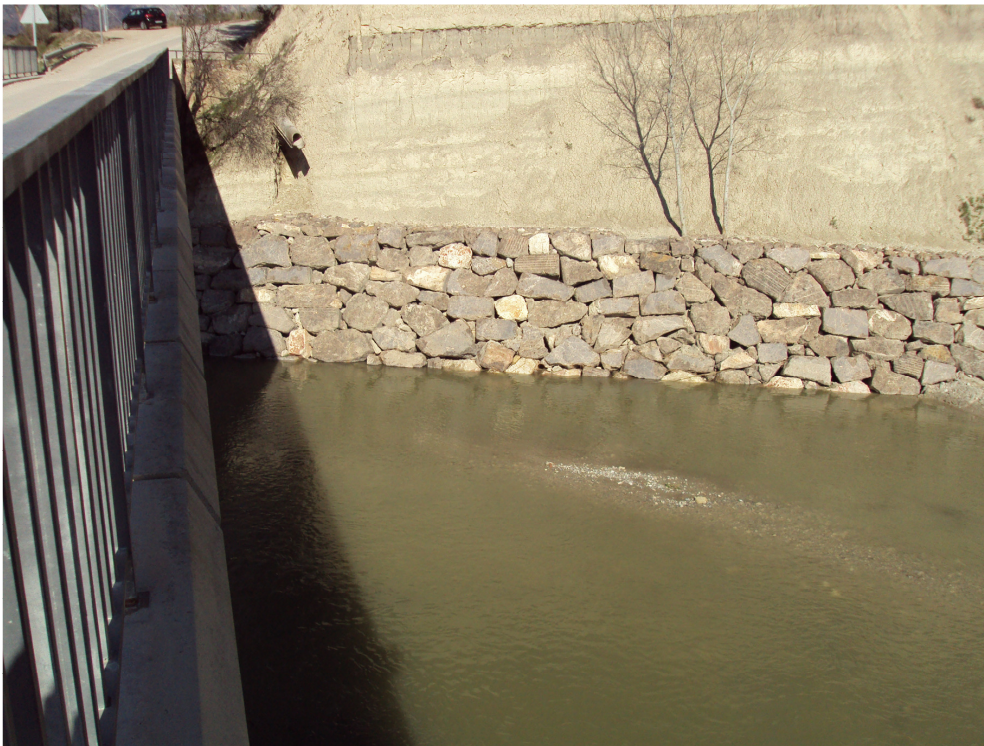
Escollera de protección de margen.
