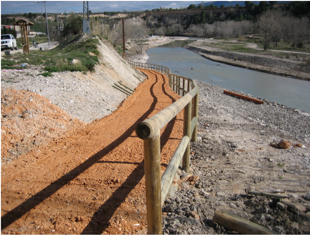
Estado del cauce tras reordenación de gravas y obras de mejora de accesibilidad.
