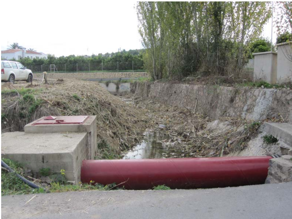
Aspecto del mismo punto tras efectuar los desbroces y retirada de RSI.
