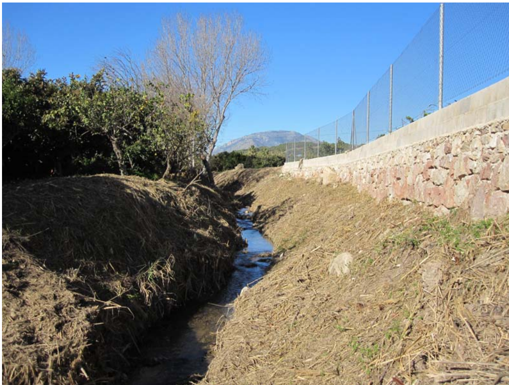
Vista del mismo punto tras la ejecución de los trabajos.
