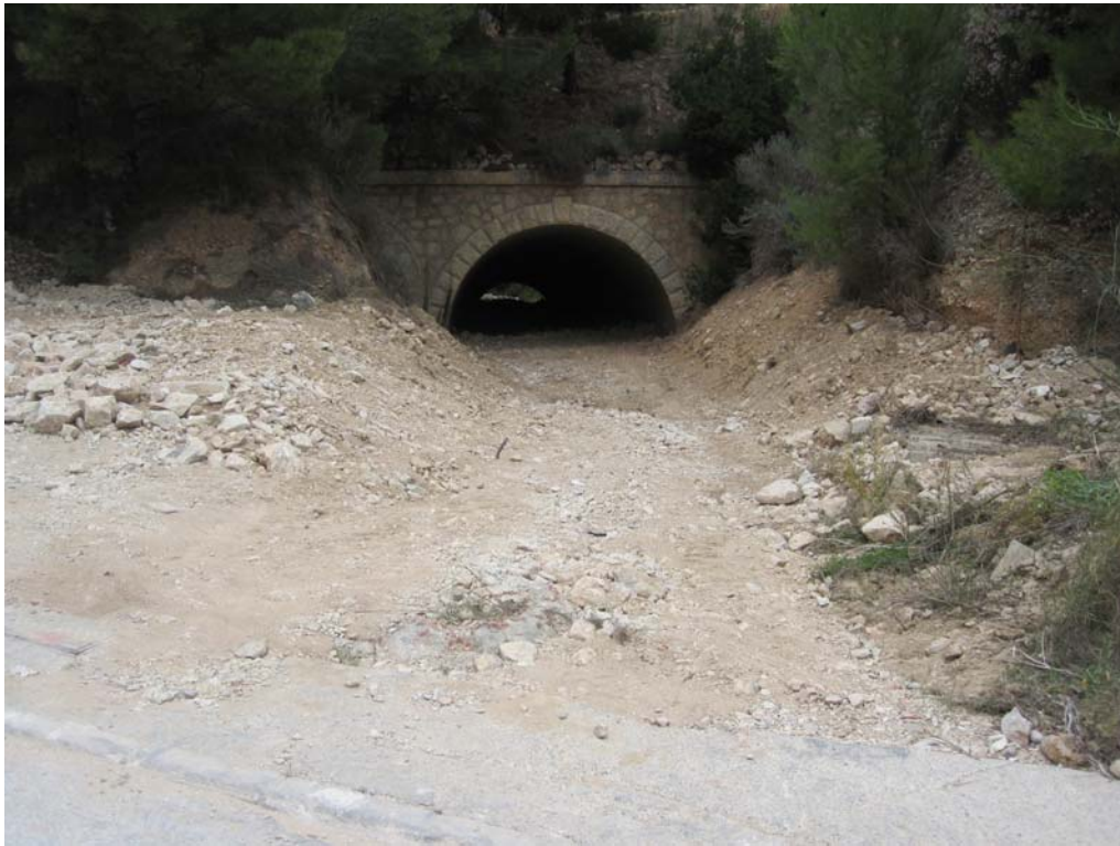
Aspecto del mismo punto tras efectuarse los trabajos.
