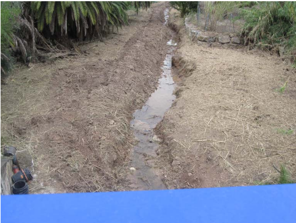
Aspecto del mismo punto tras los desbroces realizados
