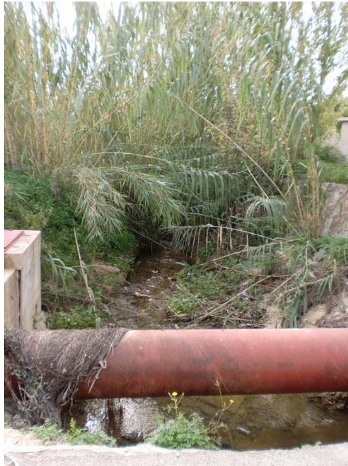
Vistas antes realizar los trabajos de desbroce.
