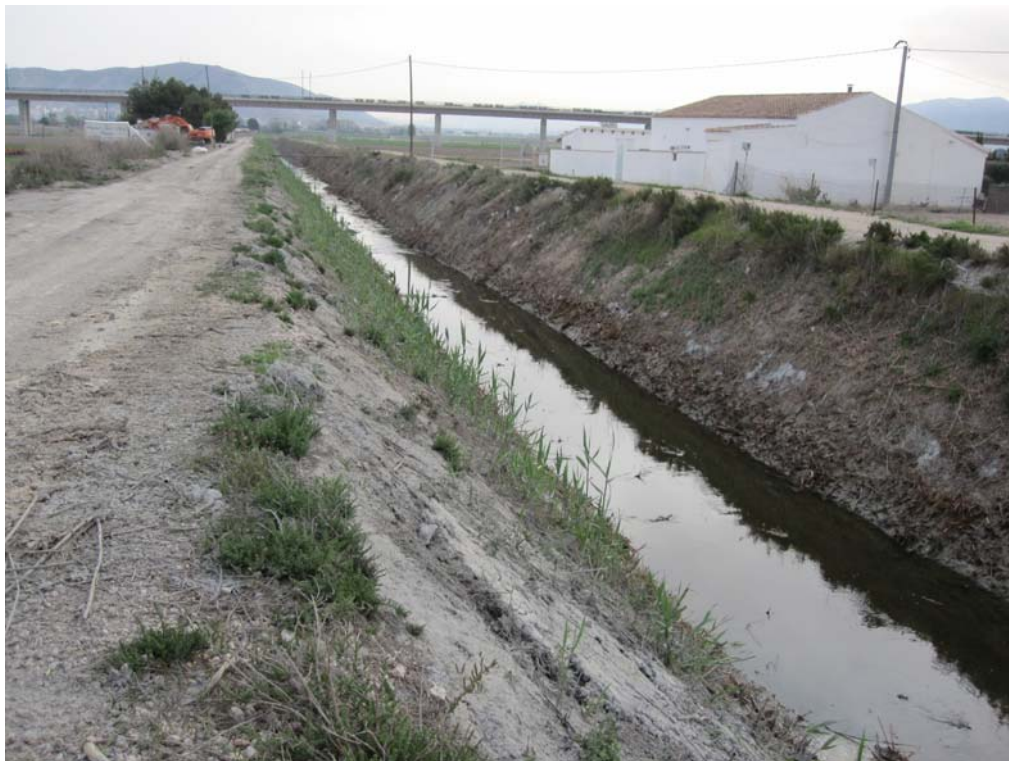
Aspecto general del tramo de acequia tras finalizar los trabajos.
