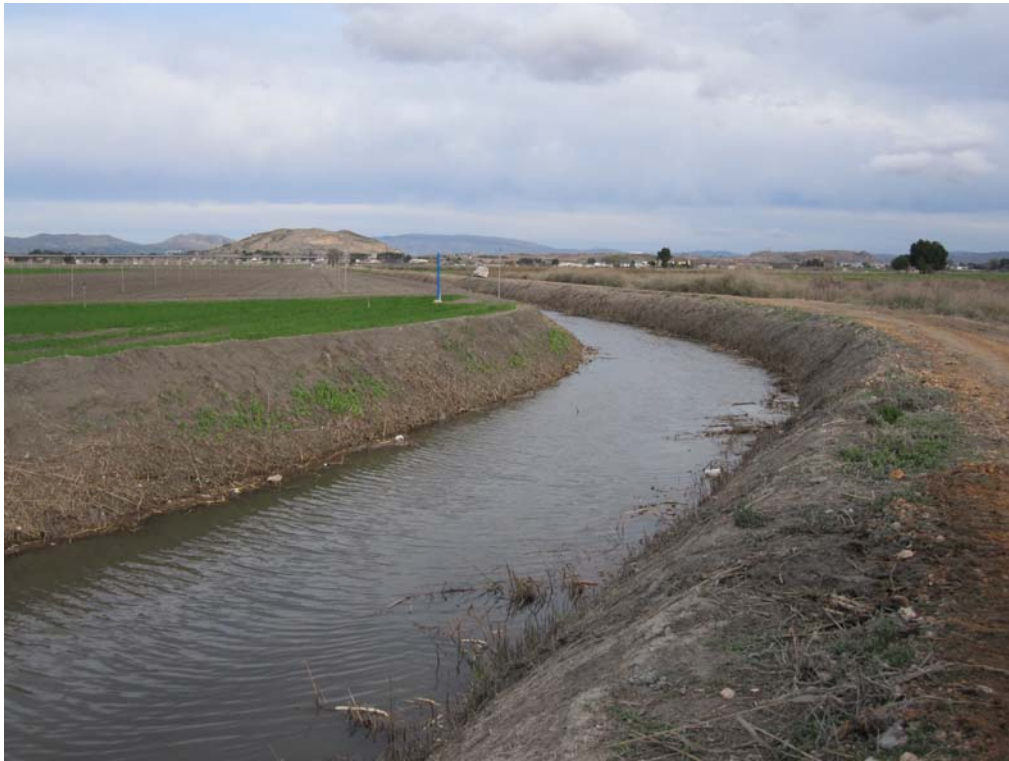
Aspecto final de los taludes y lámina de agua.
