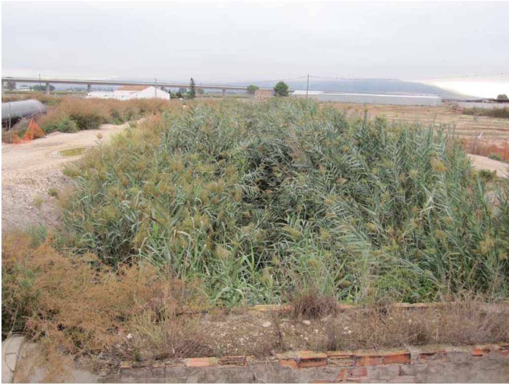
Estado previo de la espesa masa de carrizo en taludes y lecho del cauce.
