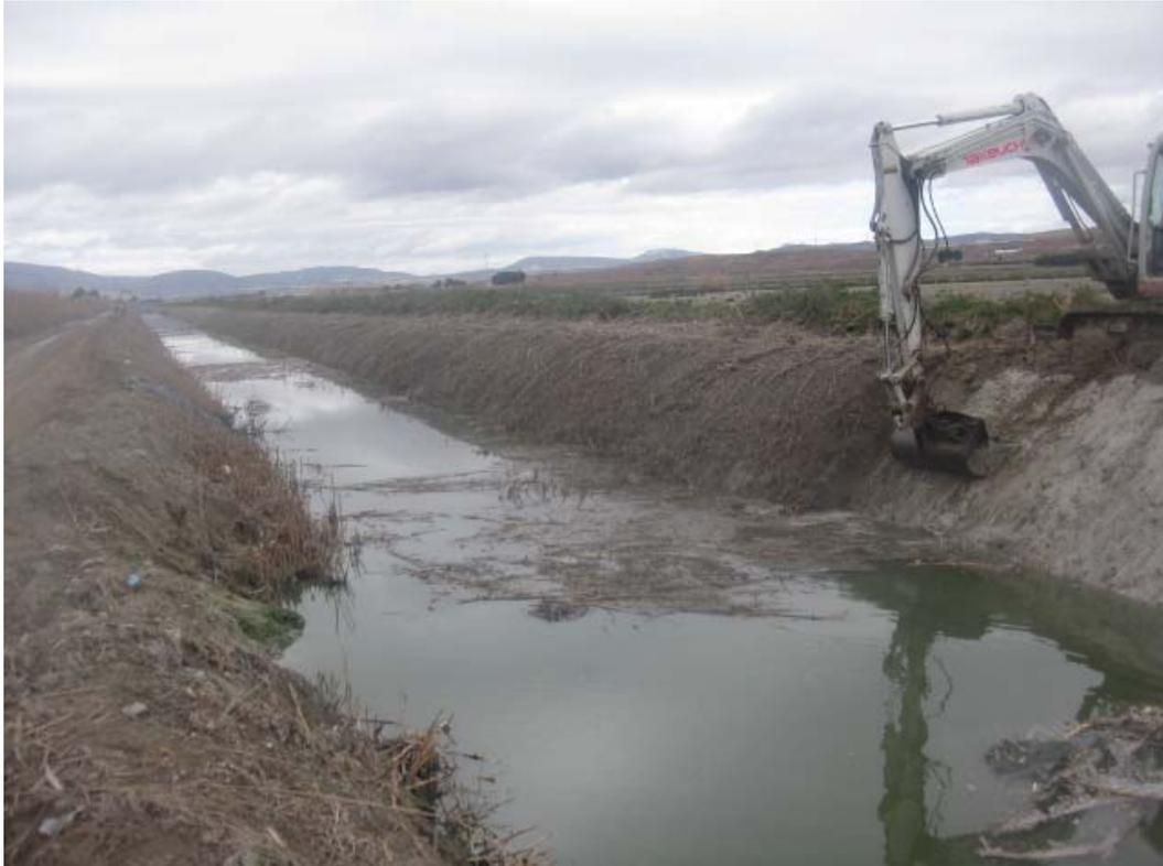
Retirada de obstrucciones del fondo y regularización de taludes
