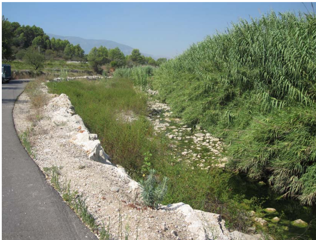
Estado del cañar antes de la actuación.
