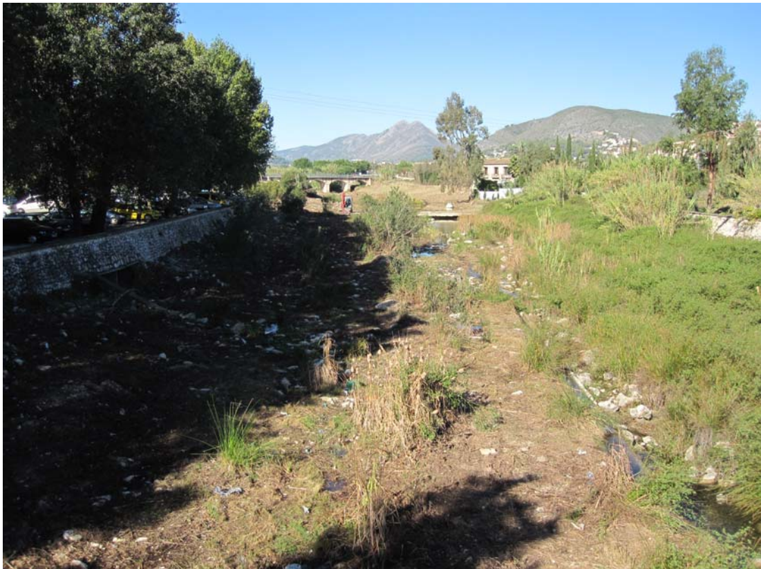
Estado del cauce tras la retirada selectiva del cañar.
