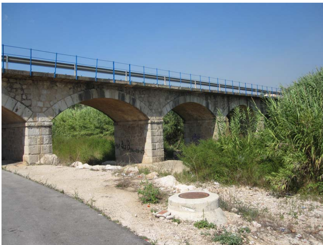
Estado del cañar antes de la actuación.
