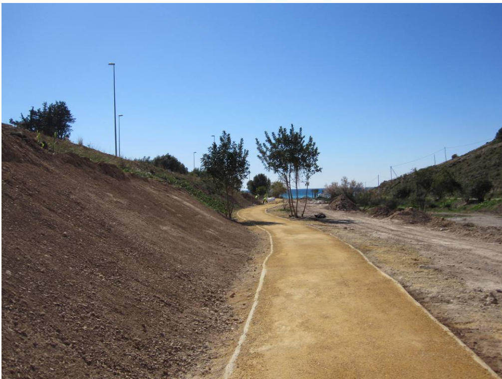
Vista del tramo final de la senda y de la reconstrucción de taludes adyacentes.
