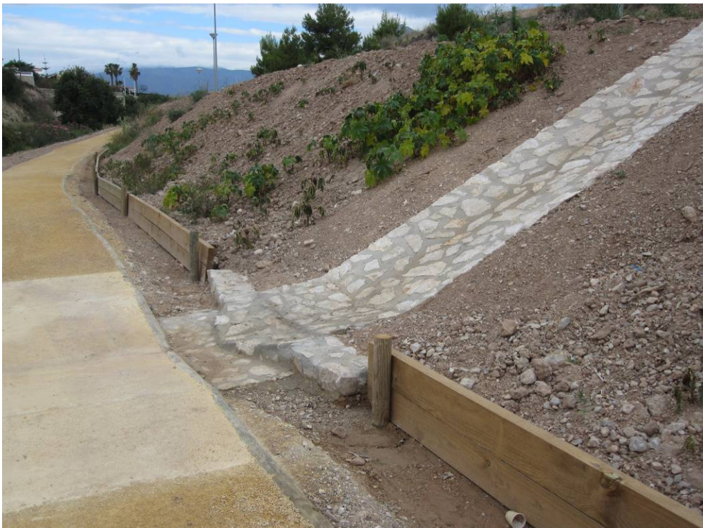
Vistas de las obras de drenaje y canalización de pluviales ejecutada.
