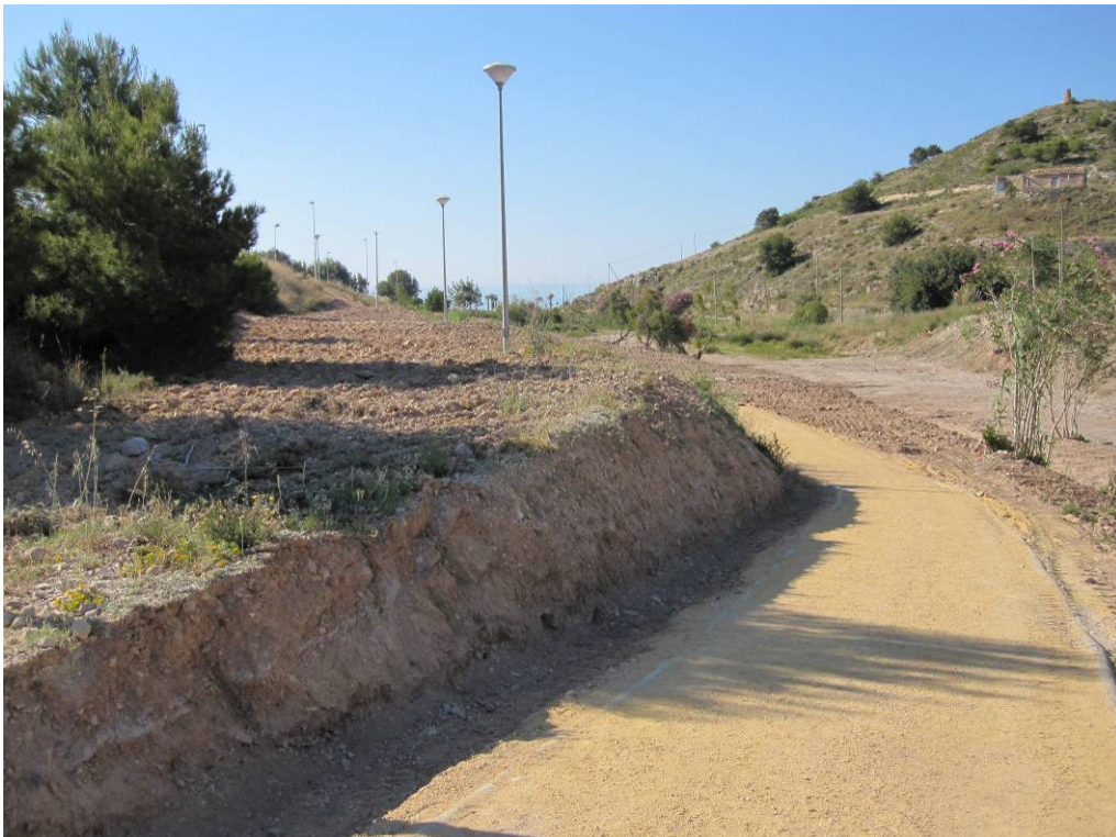
Aspecto del mismo tramo de cauce después de la actuación.
