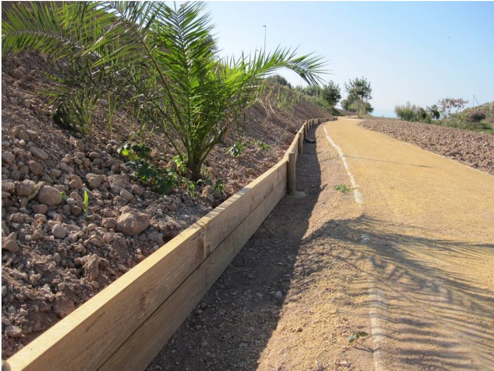
Vista de empalizadas de contención de tierras.
