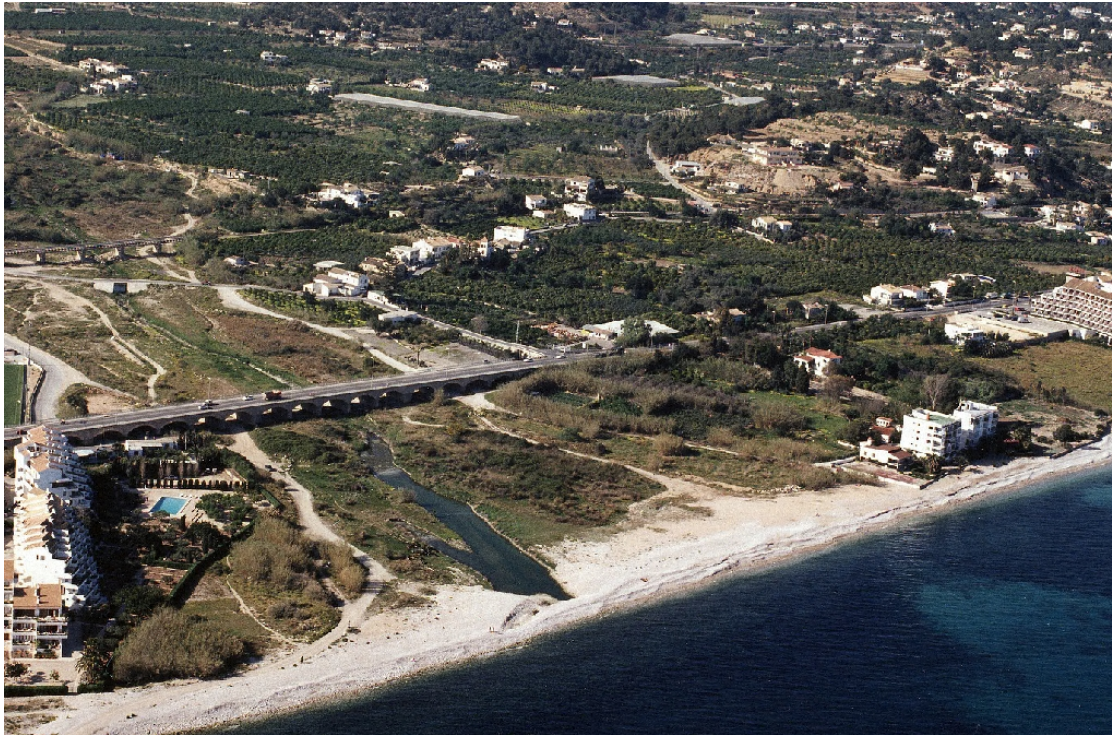
Estado del tramo final del río antes de actuar.
