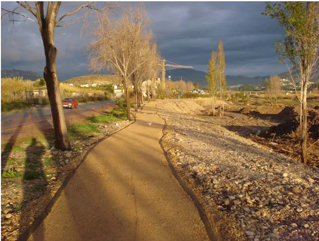
Detalle de la ejecución de senda perimetral
