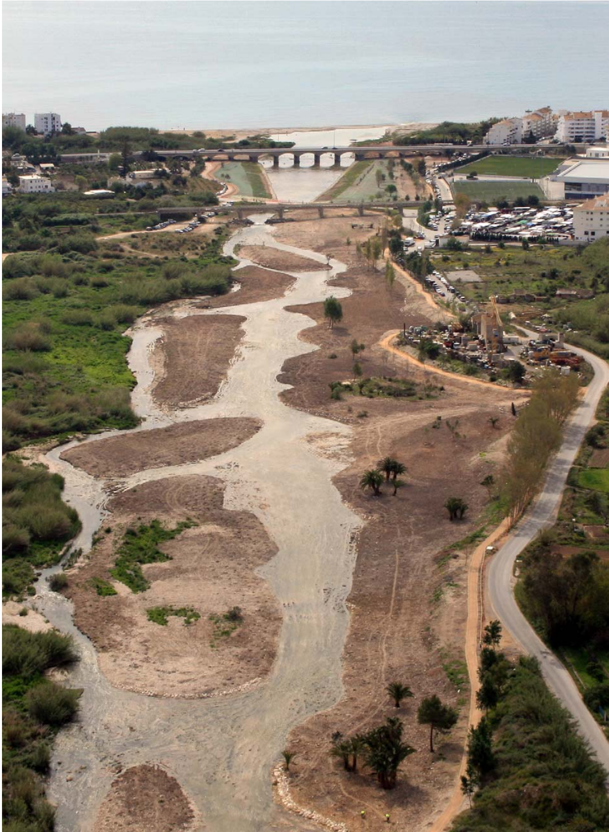
Vista general de los trabajos durante su ejecución. En primer término, reordenación de gravas. A la derecha senda perimetral, en color albero. Al fondo, en verde, geoceldas para protección del lecho.
