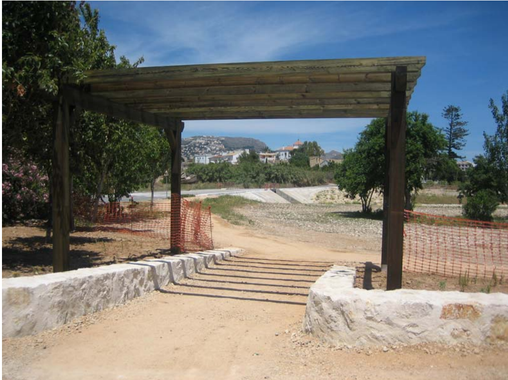
Detalle de la pérgola que da acceso a la zona estancial.
