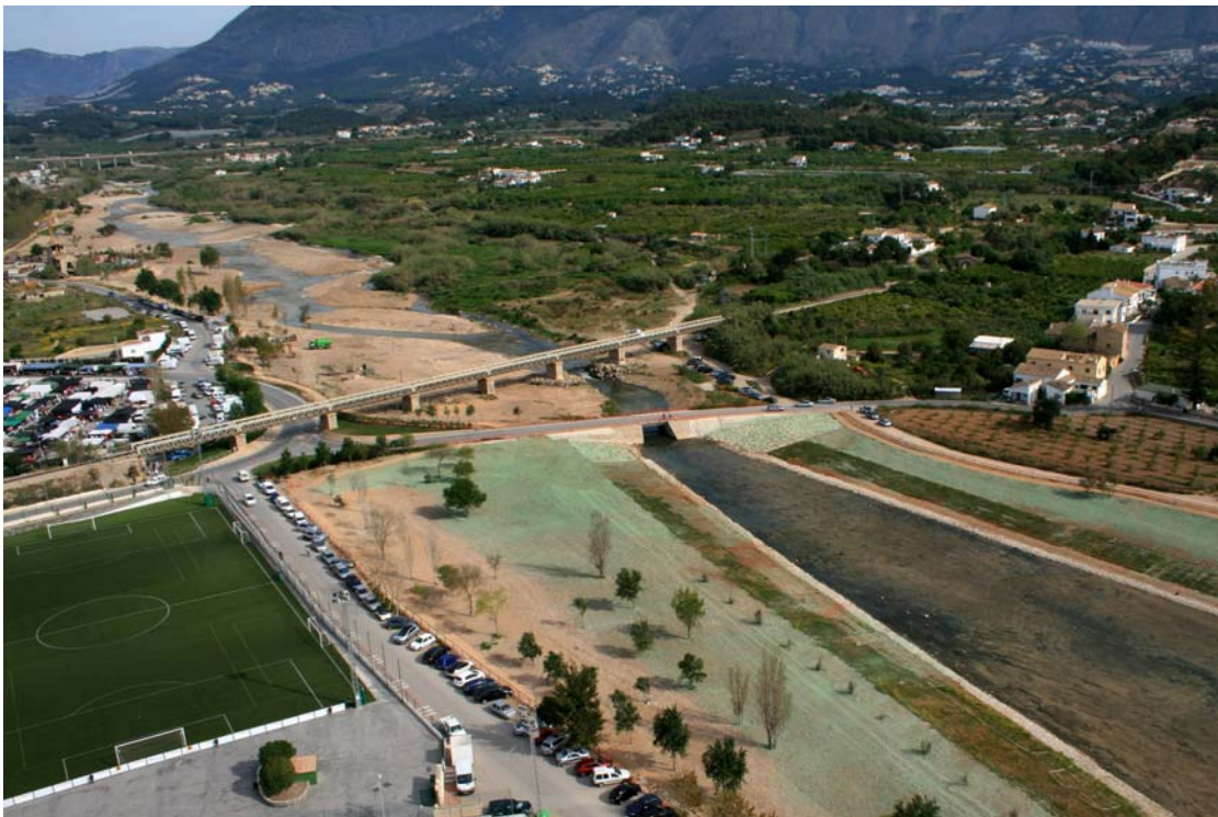
Vista aérea de los trabajos durante su ejecución (antes del crecimiento natural de las especies herbáceas plantadas mediante hidrosiembra).
