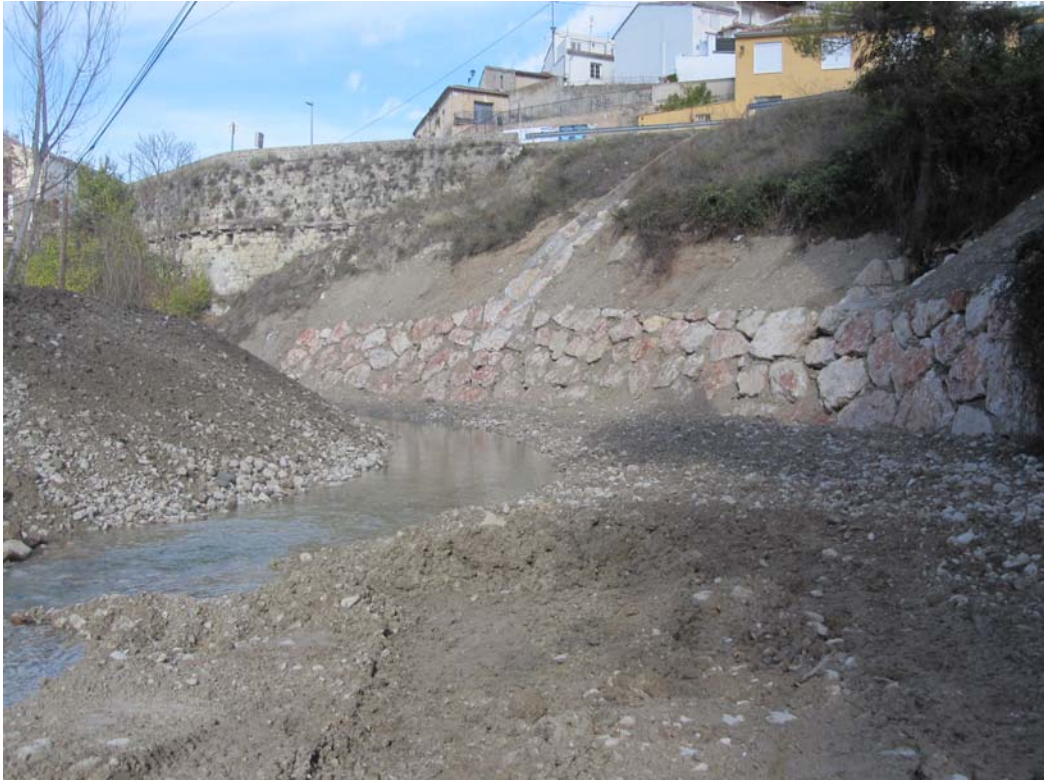
Aspecto final del talud con la nueva protección de escollera.
