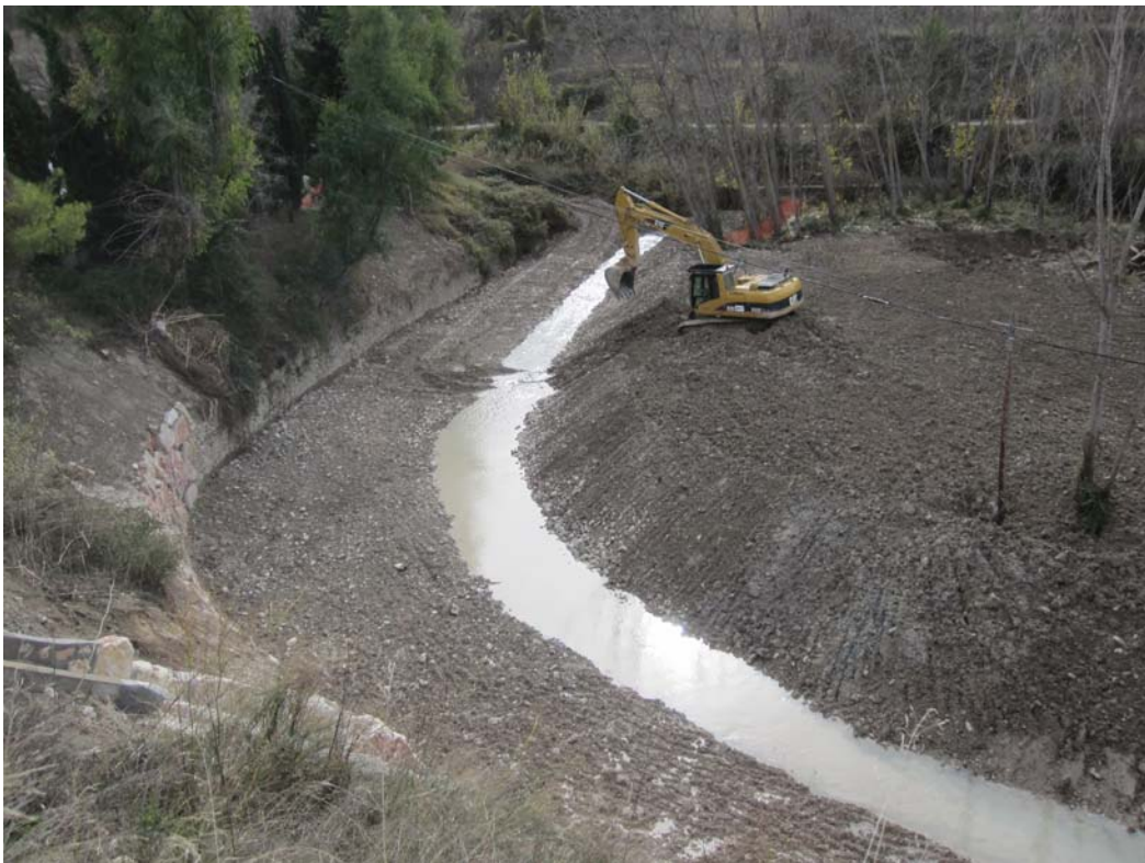
Aspecto general del tramo de río tras finalizar los trabajos.
