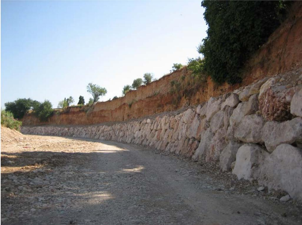
Detalle del muro de escollera construido en la margen izquierda
