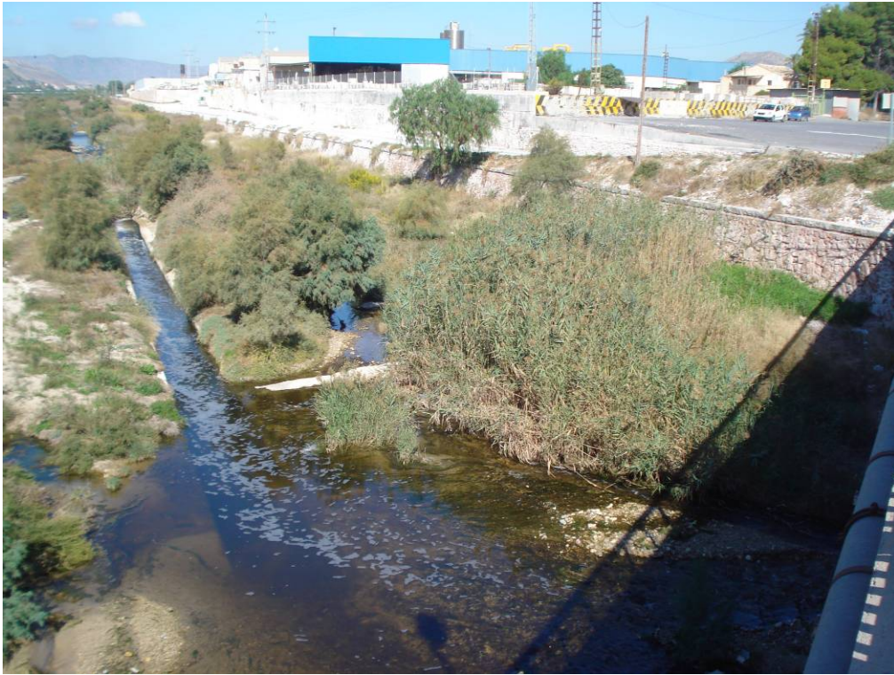
Vista de la proliferación de carrizo junto al puente de la carretera.
