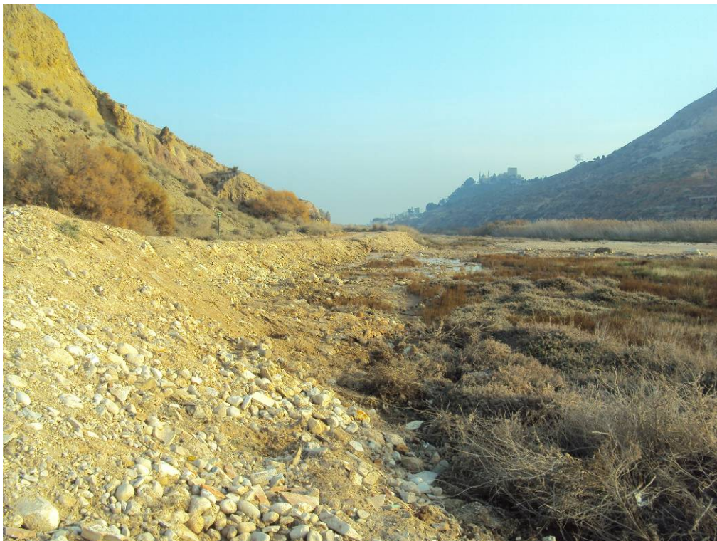
Aspecto del mismo punto de la margen del río tras la disposición de la mota.
