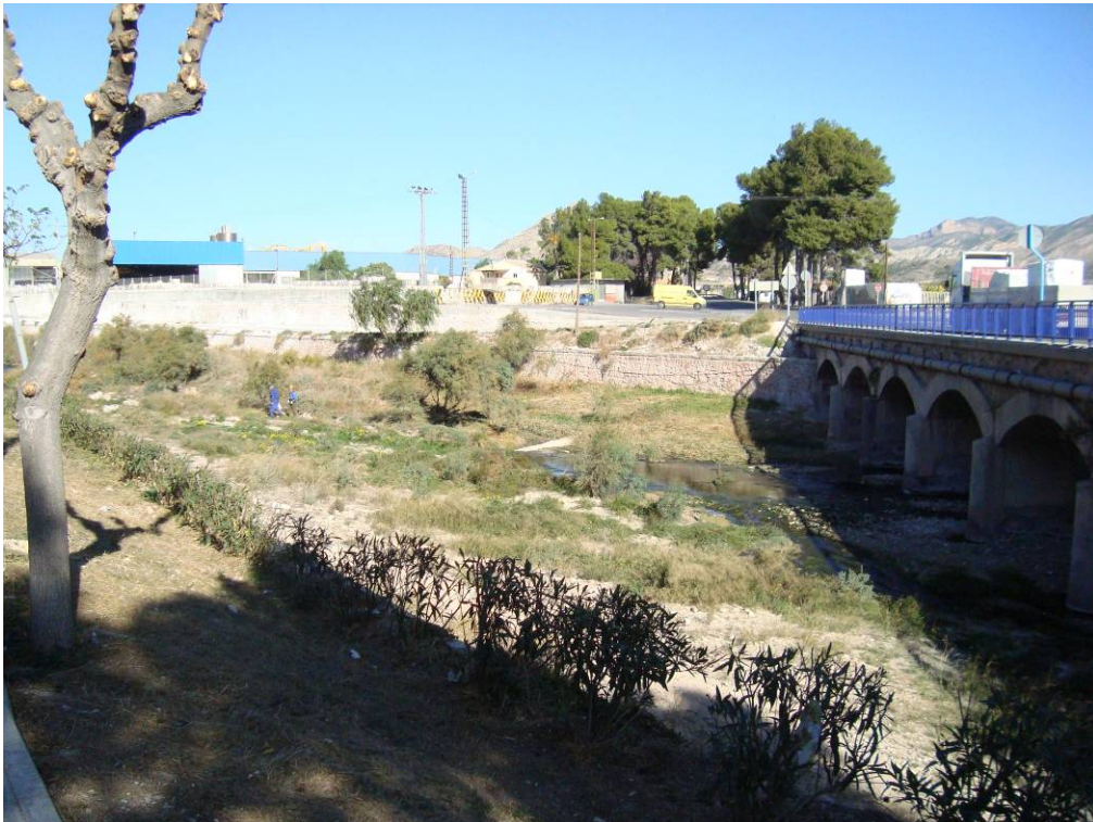
Aspecto del mismo punto tras los trabajos detallados.
