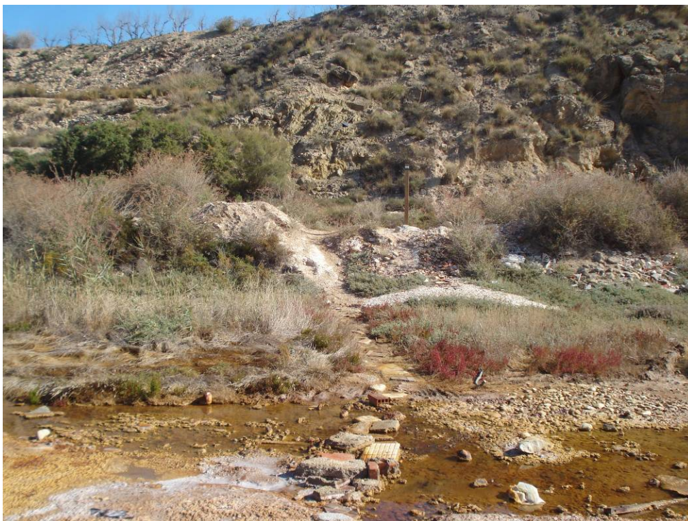
Aspecto del acceso peatonal al cauce existente antes de los trabajos, efectuado con escombros.
