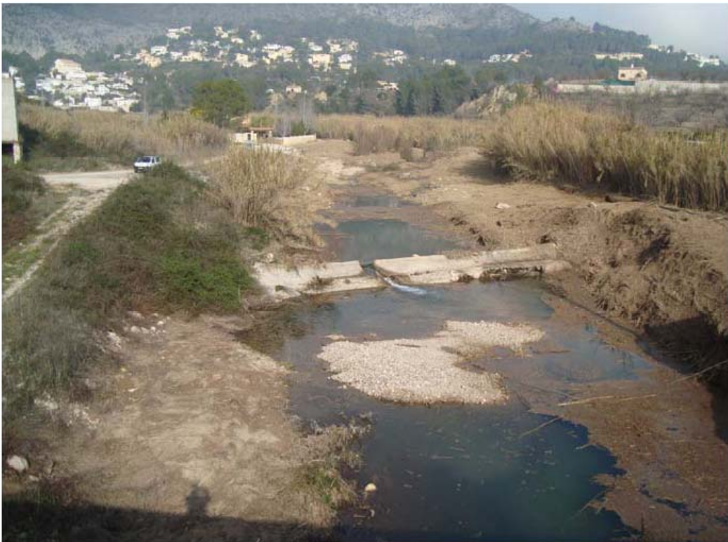
Imágenes del estado inicial y final del entorno del azud.
