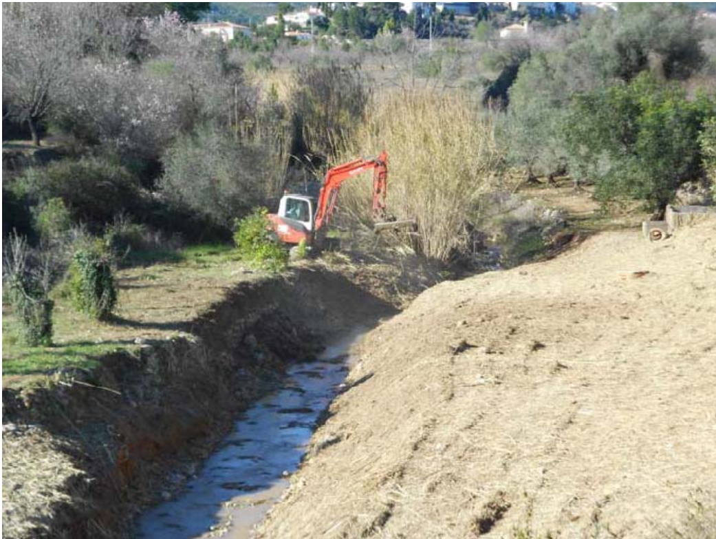
Vista del desarrollo de los trabajos.
