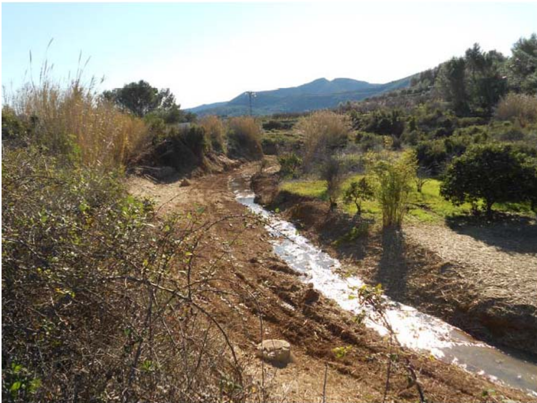
Vista del estado final tras la retirada del cañar.
