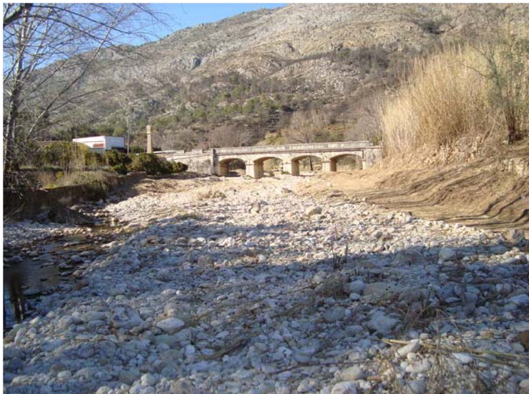
Imágenes del estado inicial y final del entorno del puente.
