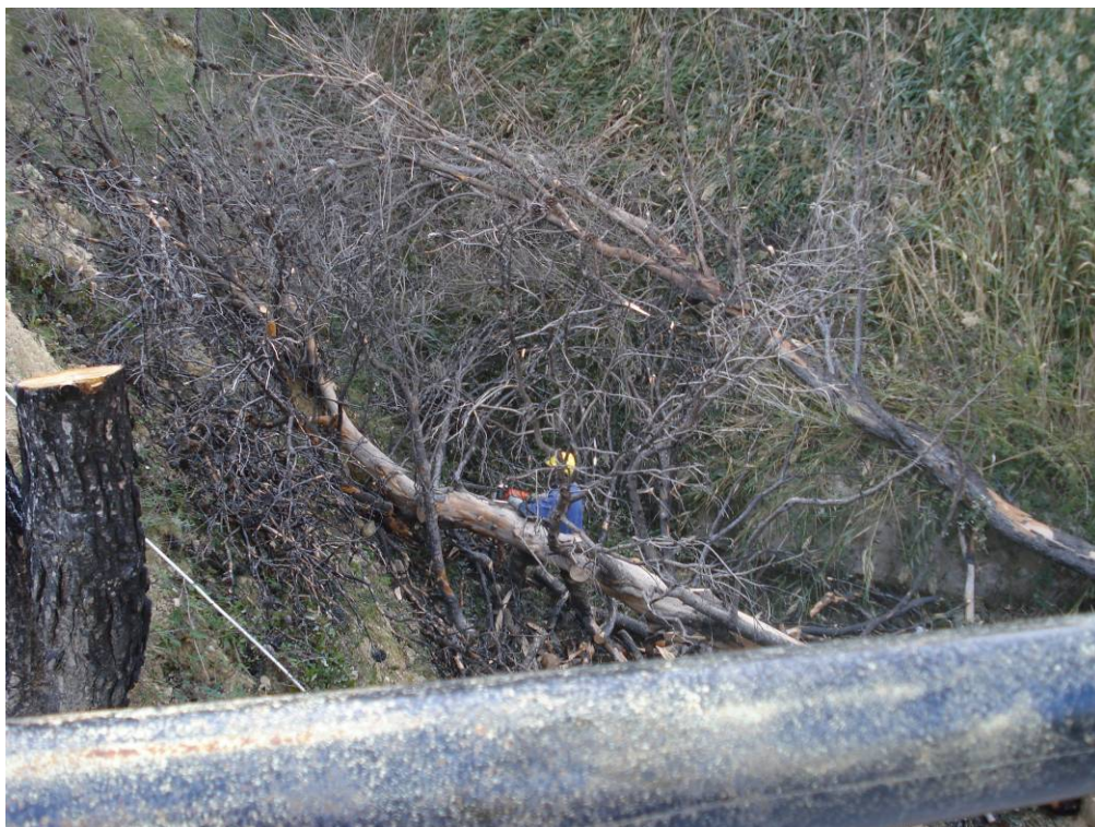
Detalle de los trabajos efectuados en el barranco de Iborra.
