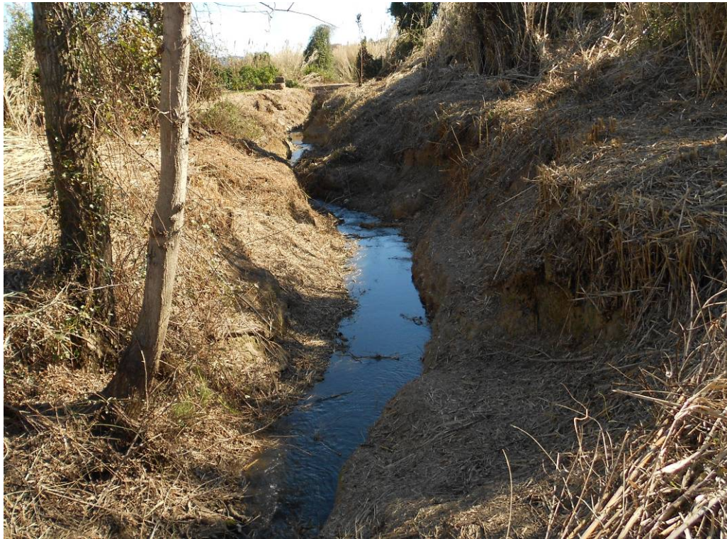
Vista del estado final del cauce tras los trabajos.
