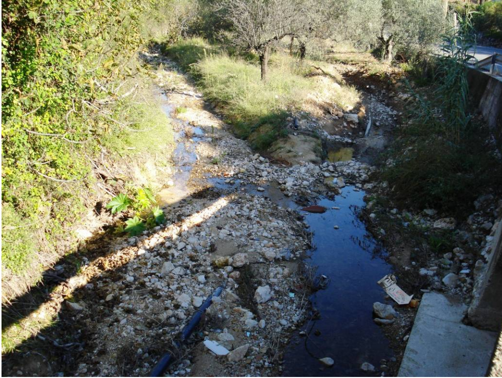
Barranco de Orbeta. Aspecto de su lecho antes de la actuación.
