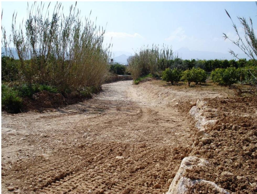
Barranco de Trullens. Aspecto de su lecho tras la actuación.
