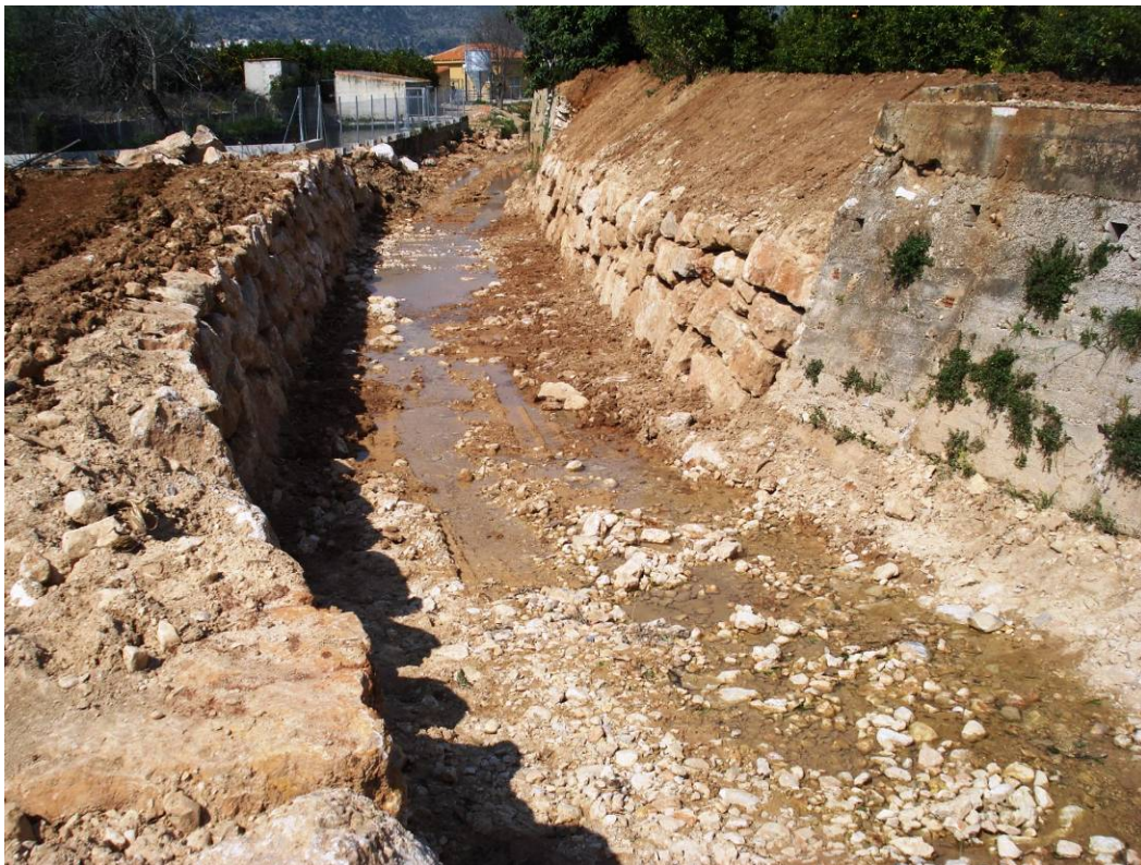
Barranto de Orbeta. Aspecto de protección de margen tras la actuación.
