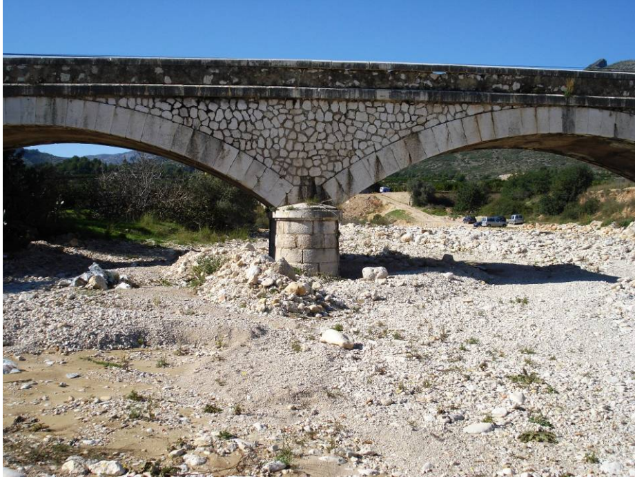
Río Girona. Aspecto de su lecho antes de la actuación.
