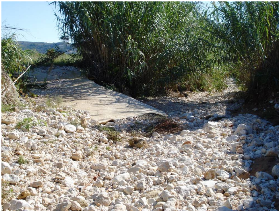
Barranco de Trullens. Aspecto de su lecho antes de la actuación.
