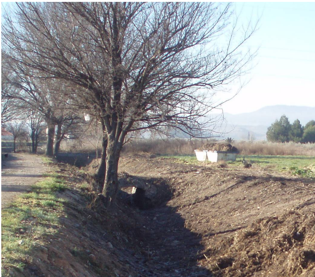
Estado final del mismo tramo de cauce tras los trabajos.
