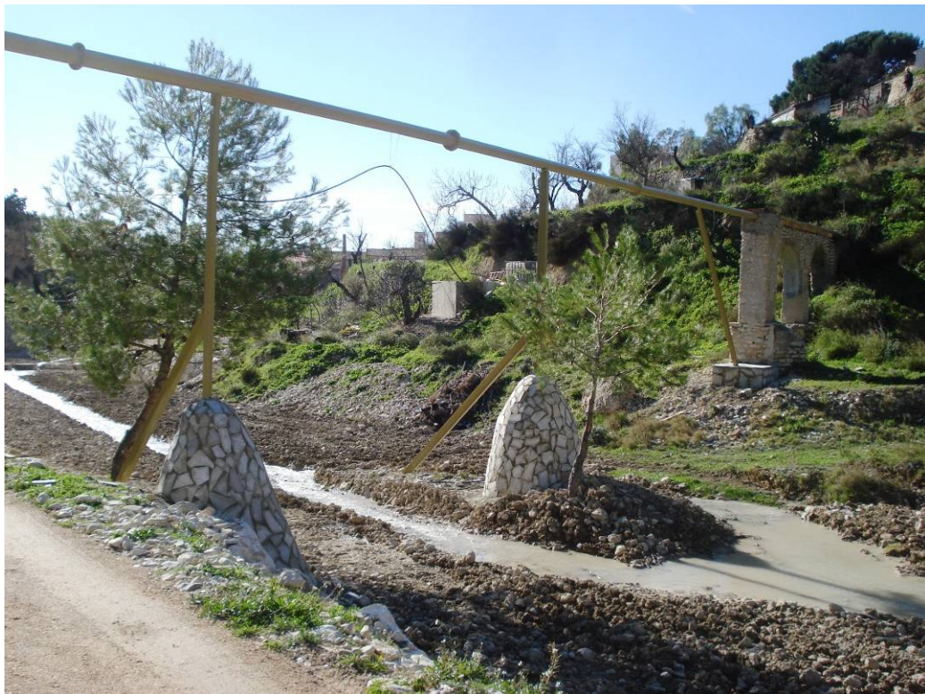
Estado final, detalle mejora estética cruce tubería existente.
