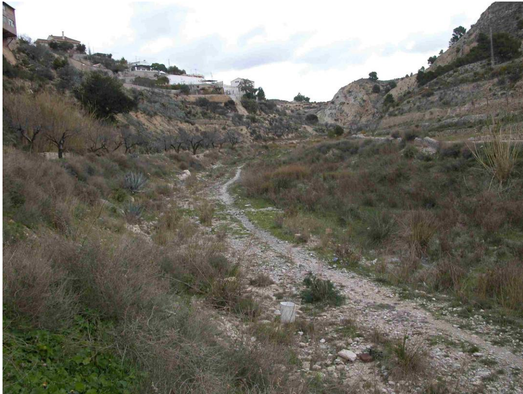
Estado inicial, vista general.
