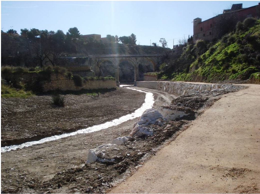
Estado final, detalle senda y defensa con escollera en entorno puente.
