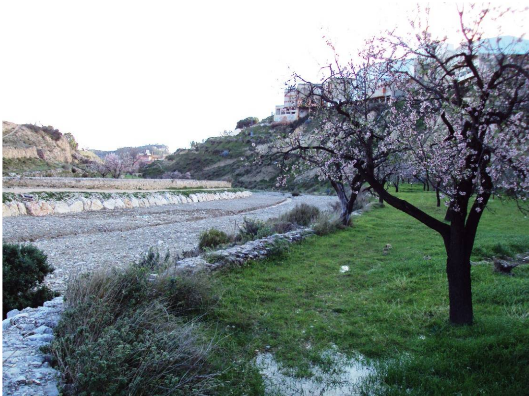
Estado final, detalle reordenación de gravas y defensa con escollera.
