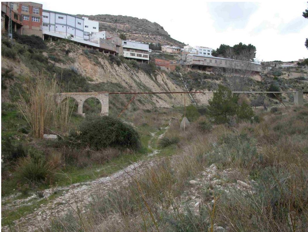
Estado inicial, detalle cruce tubería existente.
