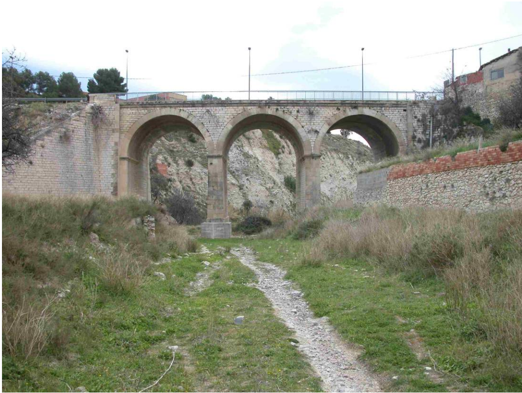
Estado inicial, detalle entorno puente.
