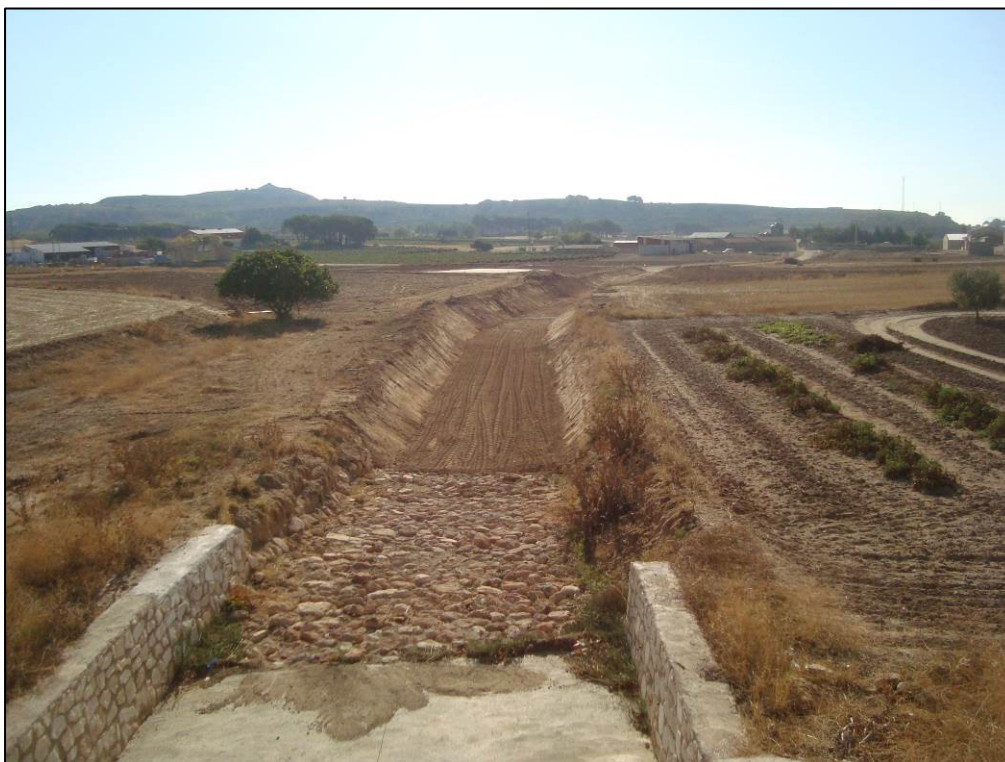
Situación después de la actuación
