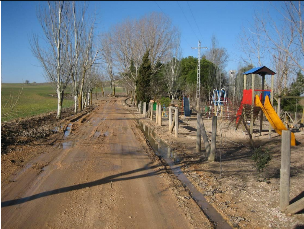
Situación antes de la actuación
