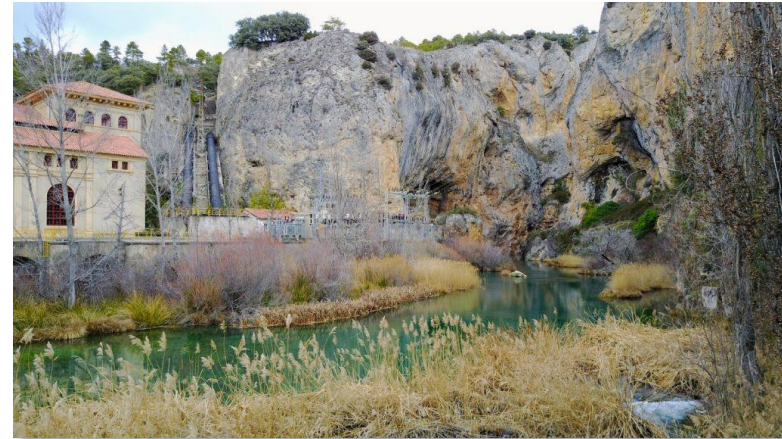
Imagen de una central hidroeléctrica en el alto Júcar
