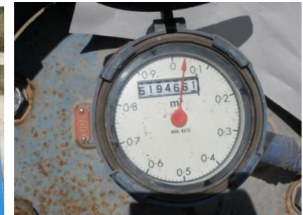
Contador volumétrico en pozo en Villena
