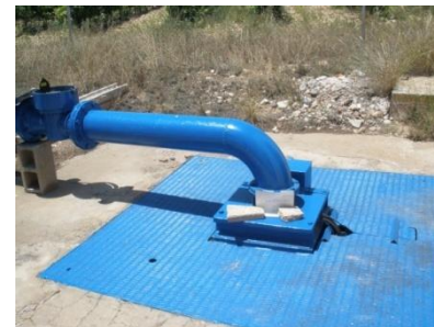
Contador volumétrico en pozo en Villena
