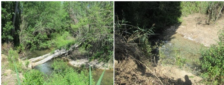
Situación anterior (izquierda) y posterior (derecha) a la adecuación hidráulica y medioambiental del río Ebrón en Castielfabib.
