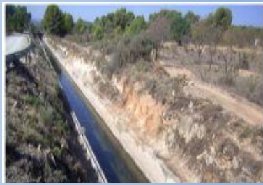
Gran reparación del canal principal del Camp de Túria. Fuente : Acuamed.
