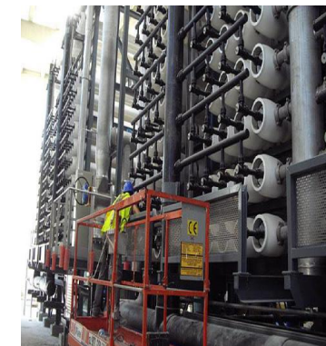
Balsa y estación de bombeo de Llanera de Ranes en la conducción Júcar-Vinalopó (izquierda) y montaje de bastidores en la desalinizadora de la Marina Baja (derecha).
