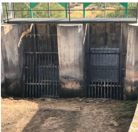
Sustitución de las compuertas de los sifones existentes
