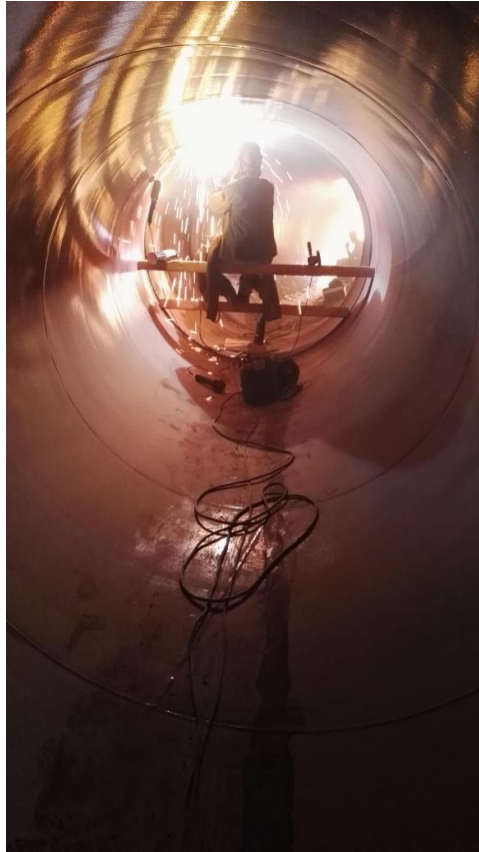
Soldadura de tubería de acero Ø2032
