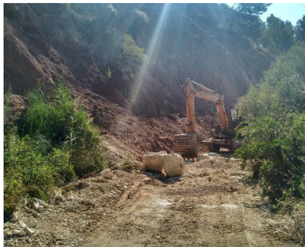
Despeje y limpieza del camino
