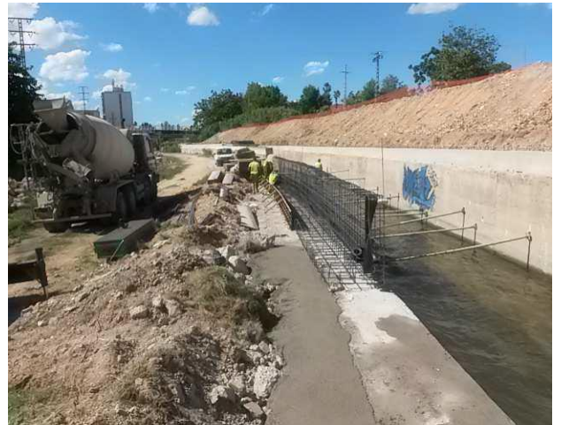
Ferrallado muro ménsula
