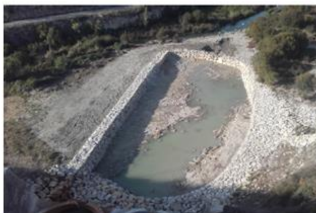
Colchón amortiguador finalizado (31/10/17)
