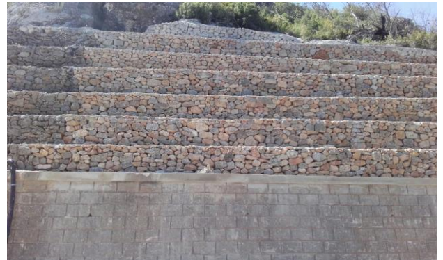
Muro de mampostería
