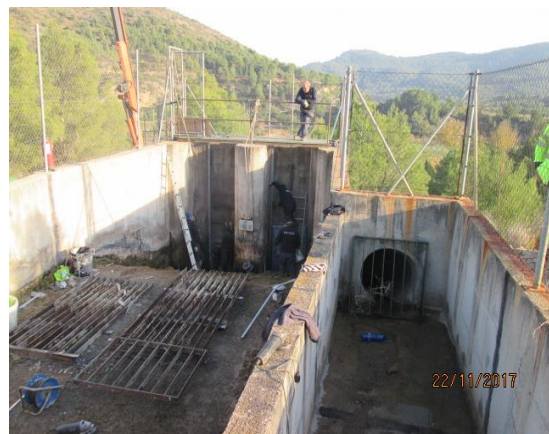
Sustitución de las compuertas de los sifones existentes
