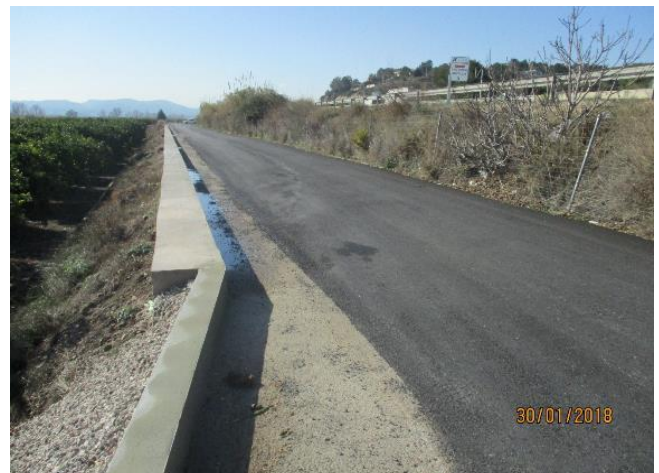
Asfaltado bituminoso y desbroce mota
