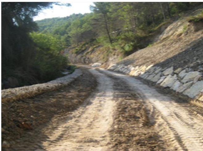
Retaluzado y colocación de escollera
