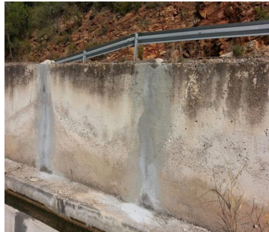
Reparación de varios tramos del cajero del Canal
