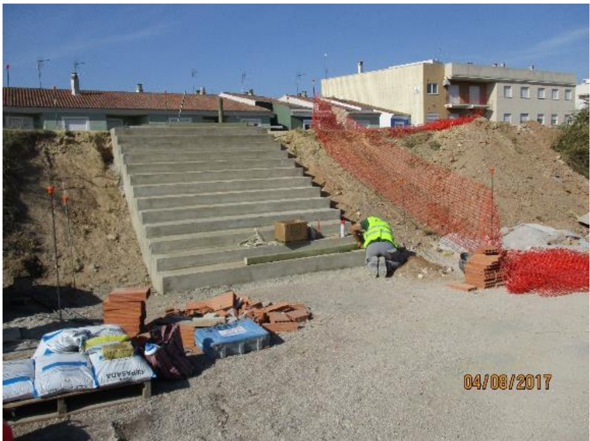
Escalera de acceso al río Júcar en Polinyá de Xúquer.
