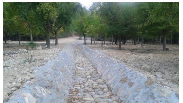
Cuneta de mampostería
