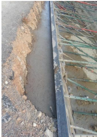
Reparación de varios tramos del cajero del Canal
