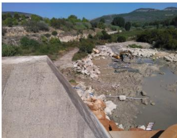
Retirando arrastres y amontonando escollera
