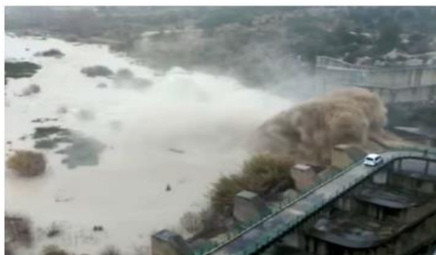
Apertura desagüe de fondo el 19/12/16
