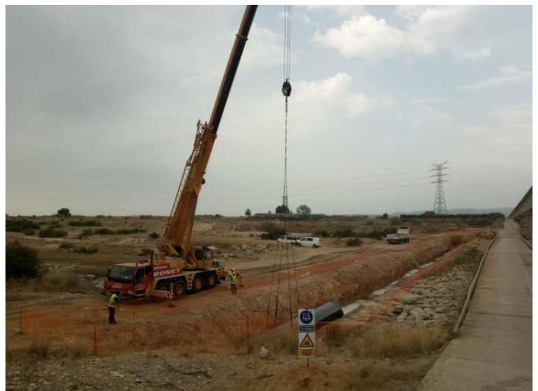
Colocación de tubería de acero Ø2032
