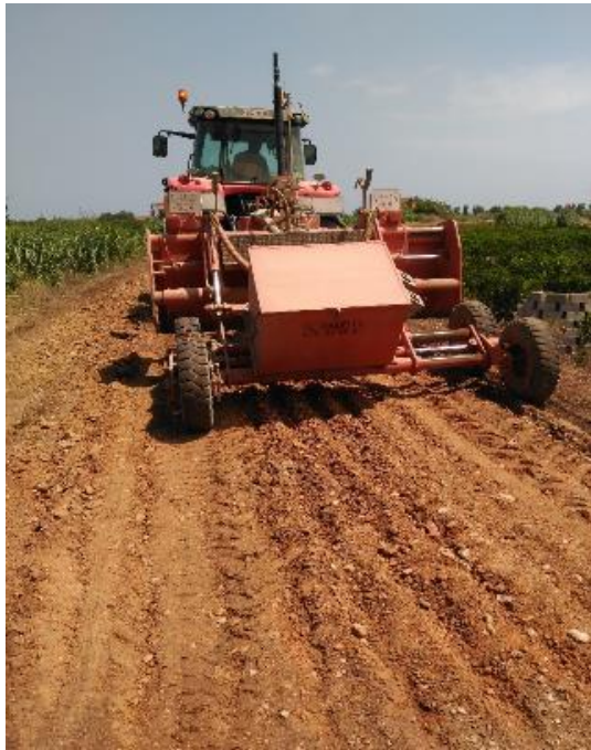
Ripado y nivelado de la mota del río Júcar en la Ribera
