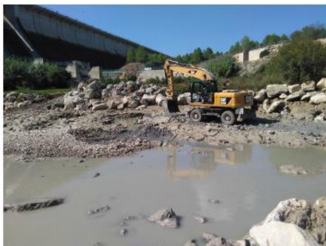
Retirando arrastres y amontonando escollera
