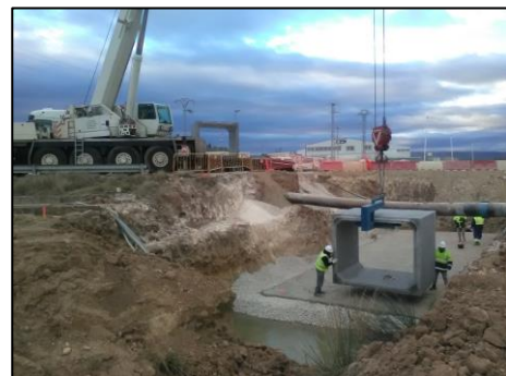
Marcos en obras de drenaje transversal
