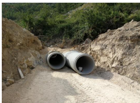
Colocación de tuberías
