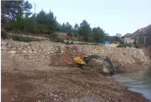
Ejecución del muro de escollera aguas abajo de la Presa de Vallat
