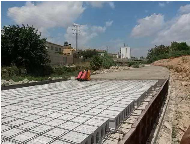
Mallazo, conectores verticales y placa alveolar
