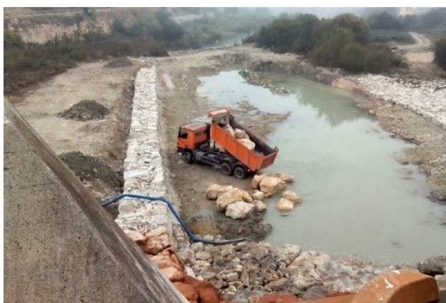
Refuerzo escollera pie de vertedro desagüe de fondo
