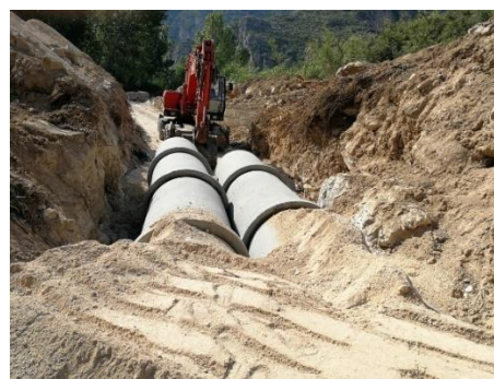
Colocación de tuberías
