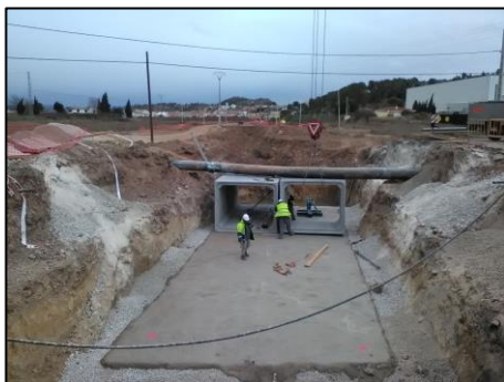
Marcos en obras de drenaje transversal
