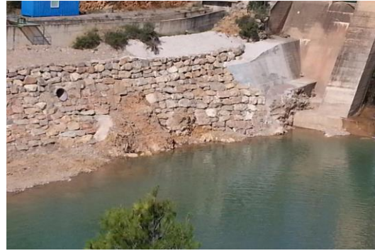
Ejecución del muro de escollera aguas abajo de la Presa de Vallat
