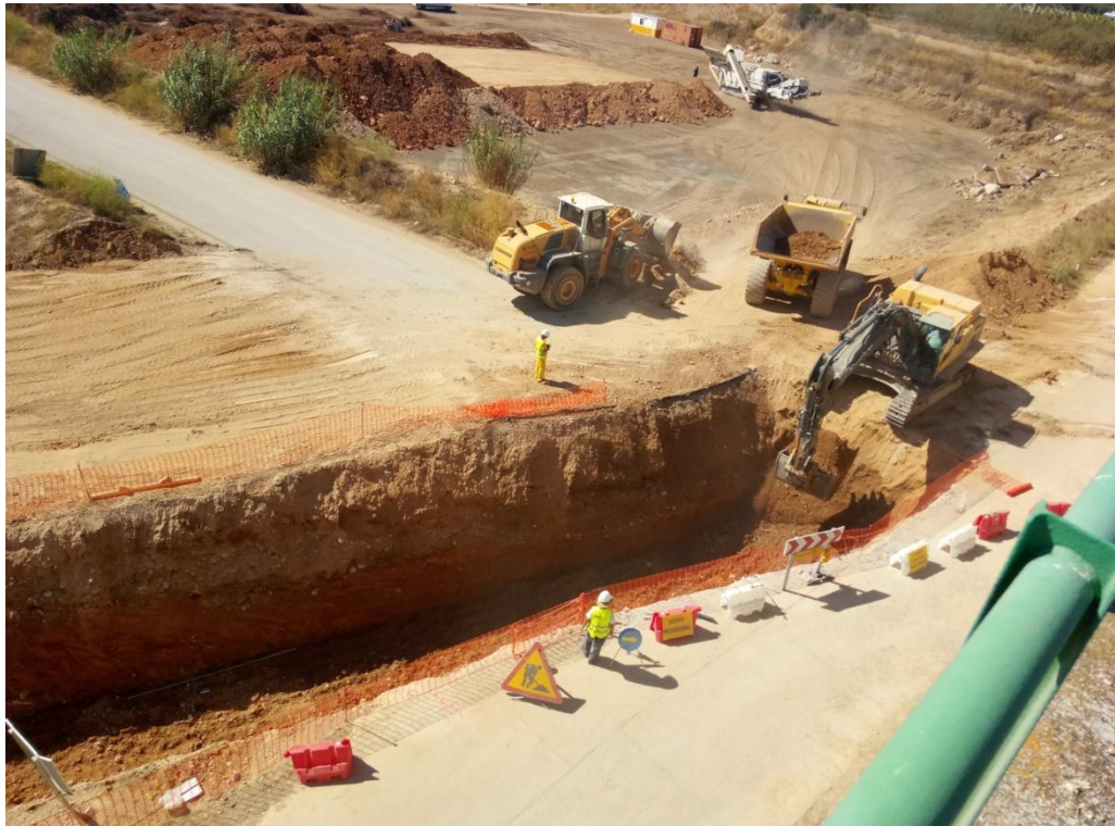
Excavación para conducción principal
