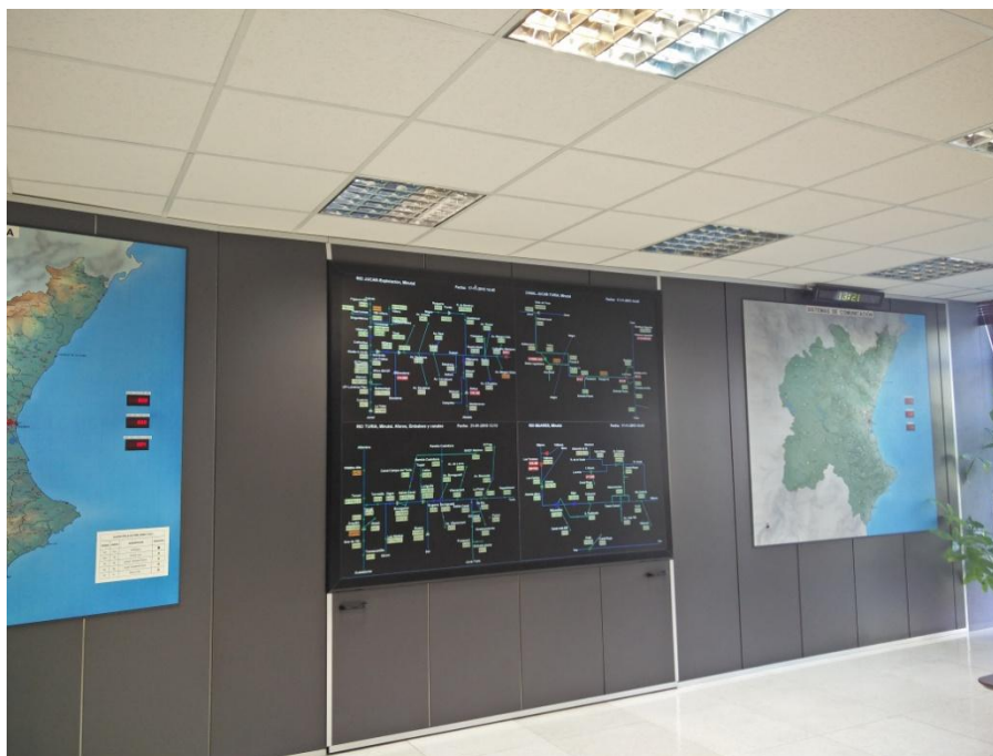
Paneles de control del SAIH
