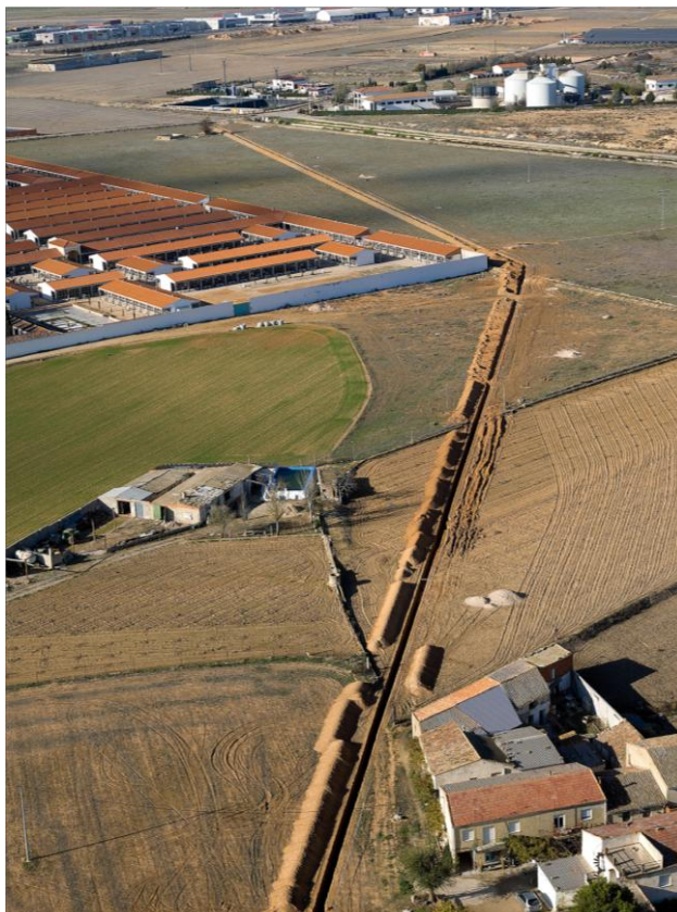
Vista parcial ejecución salmueroducto
