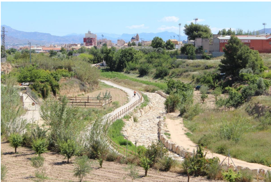
Situación del cauce a su paso por la zona agrícola de Aspe
