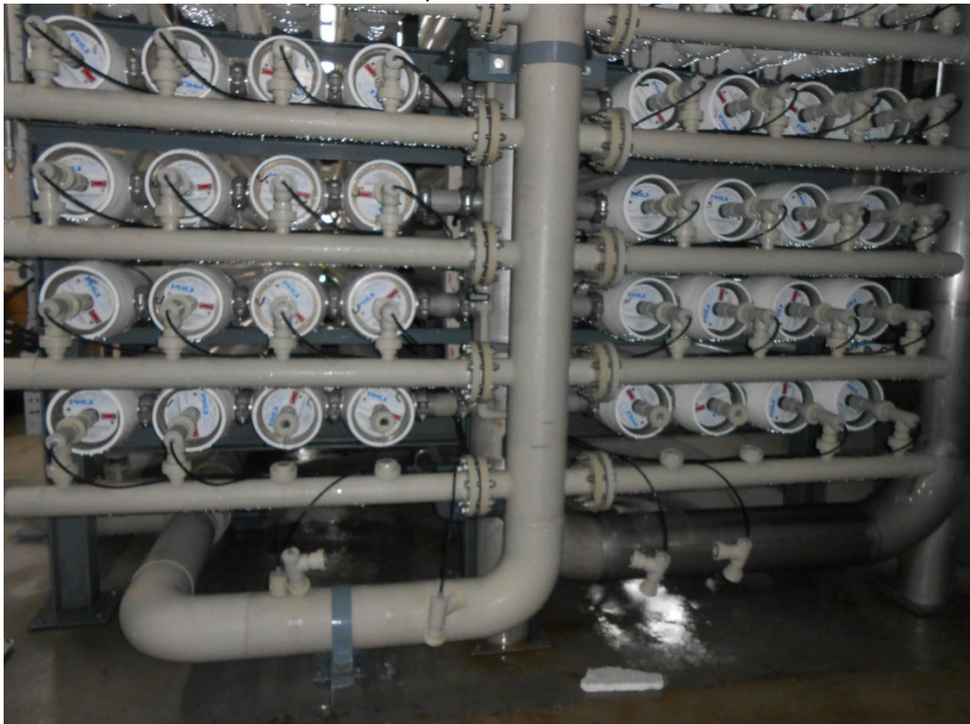
Membranas de ósmosis inversa
