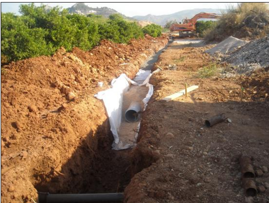
Colocación de tubería en zanja en zona agrícola.
