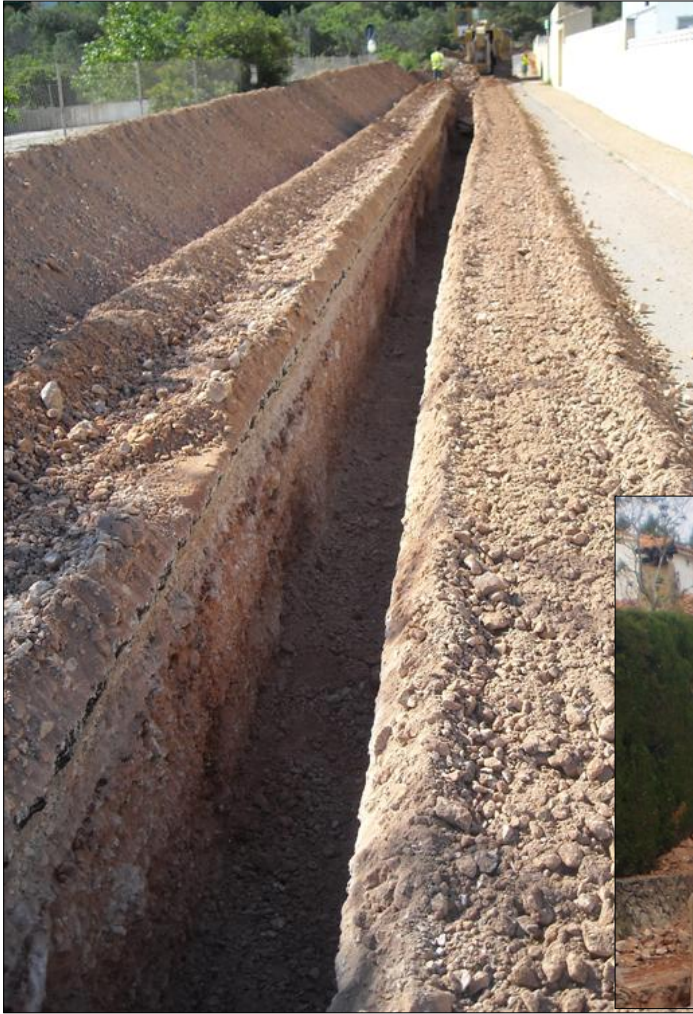
Apertura de zanjas en viales urbanos con zanjadora
