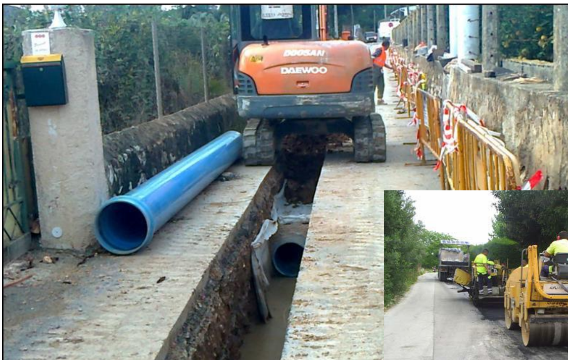
Colocación de tubería en zanja en vial urbano y aglomerado.
