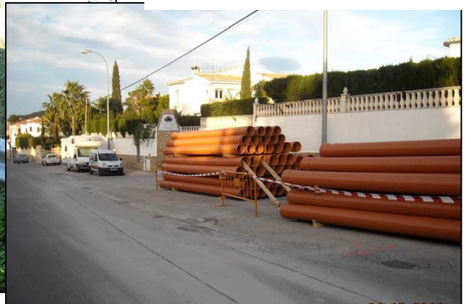
Tubos de PVC corrugados para colectores por gravedad
