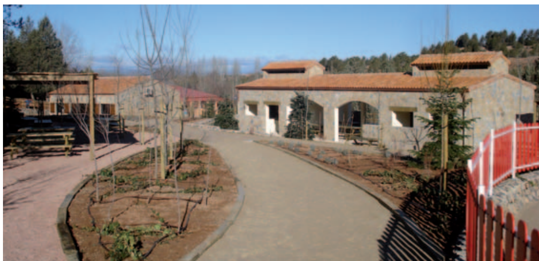
Vista general del Aula de Naturaleza en Fuente Cerrada, Teruel.
