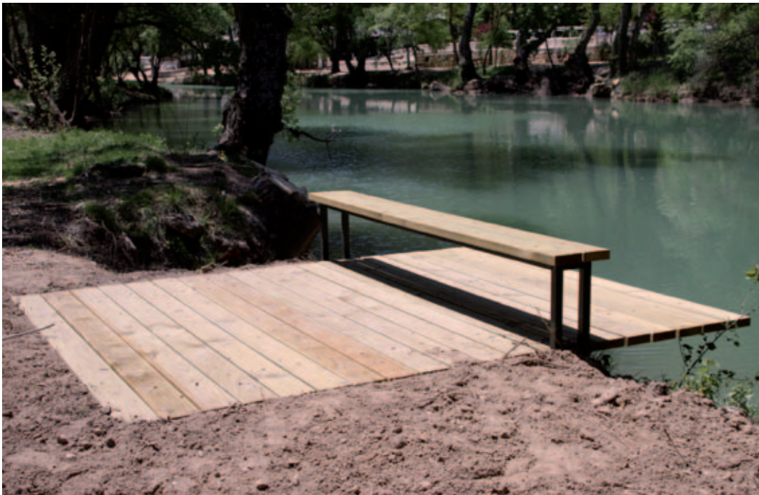
Construcción de puestos de pesca.
