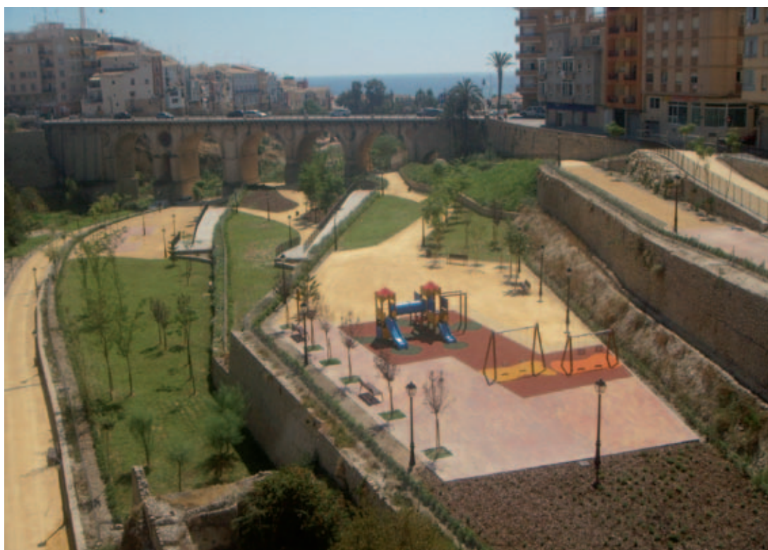
Vista panorámica desde el puente del ferrocarril.
