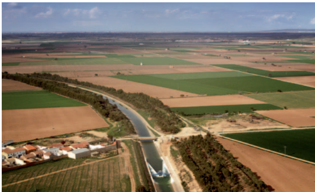
Obra de derivación del Acueducto Tajo-Segura.
