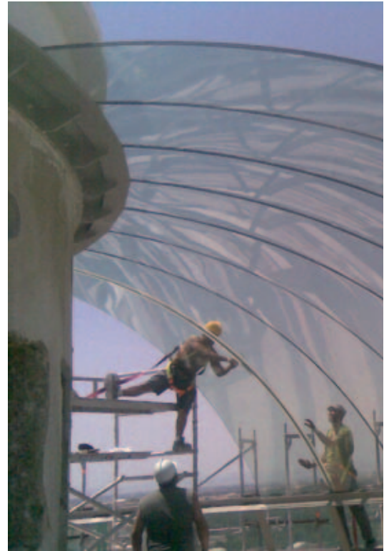
Detalle de los trabajos de la superficie acristalada.
