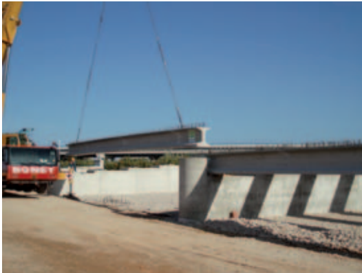
Prolongación del puente.
