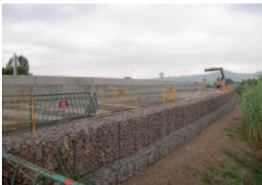
Muro de gavión.
