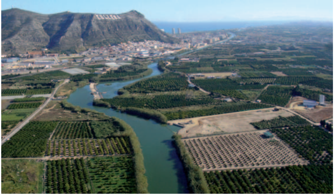
Obra de toma y estación de bombeo Marquesa junto al azudde la Marquesa, con Cullera al fondo (Tramo A).
