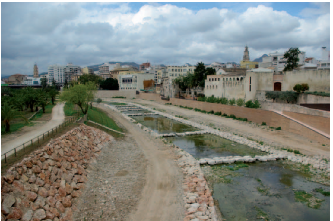
Obra de defensa y adecuación del río Serpis en Gandia.
