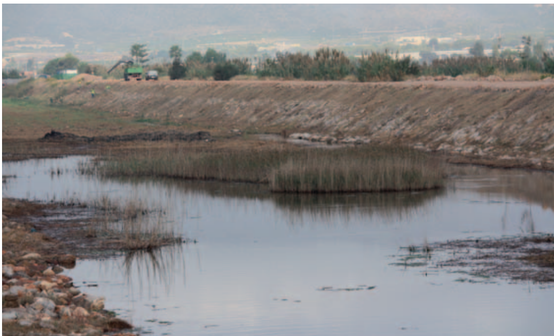
Acondicionamiento del Río Seco cerca de la desembocadura.
