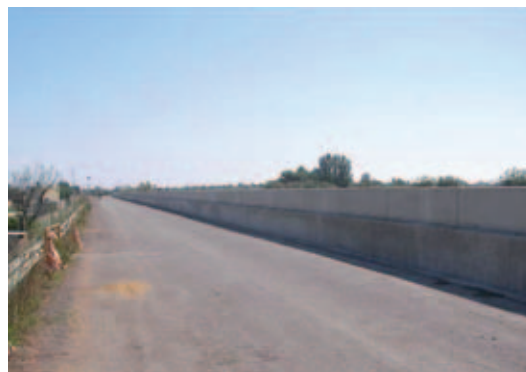
Vista del recrecido de cajero desde el camino de servicio.
