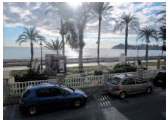
Estación de bombeo Parque de Elche en Playa de Poniente.
