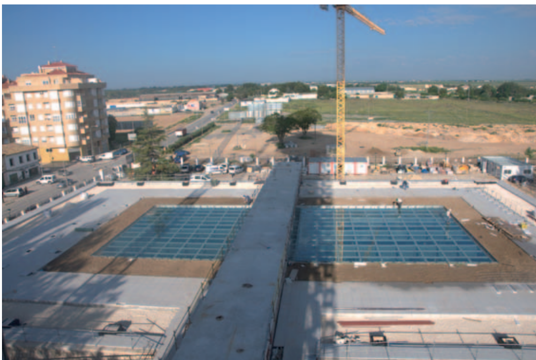
Vista de la obra y recinto ferial.
