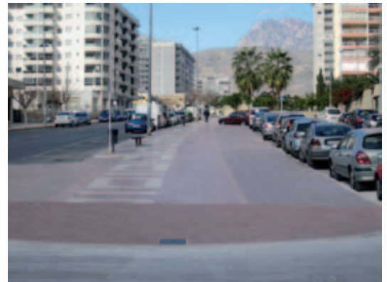
Canalización eléctrica entre la estación de bombeo Cala Bajo y nuevo centro de transformación.
