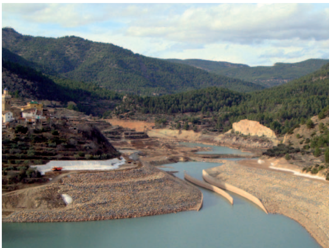
Vista de las obras del embalse de Arenós.
