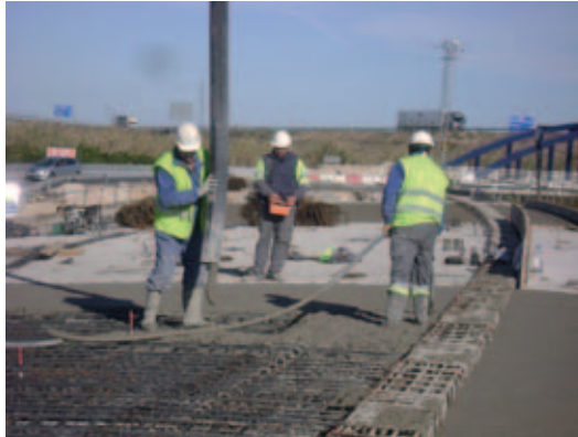
Trabajos de hormigonado.
