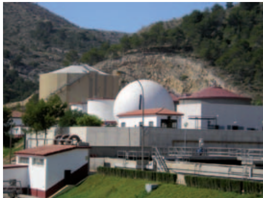
Línea de gas actual de la EDAR de Benidorm.
