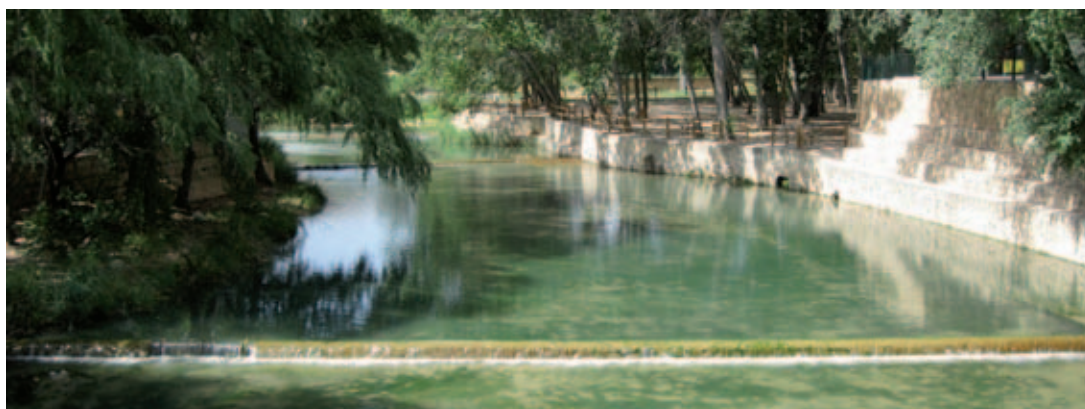
Laminadores de agua arriba del puente.
