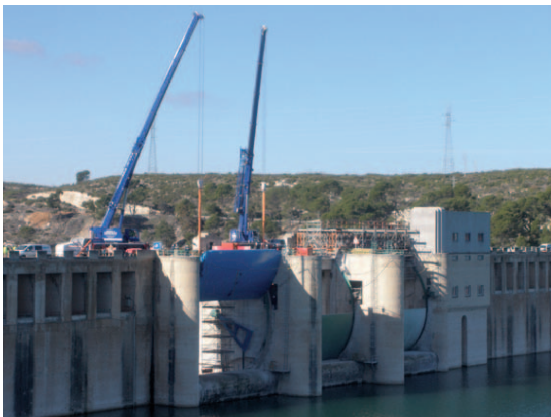
Sustitución de las compuertas existentes por otras de nuevo diseño.
