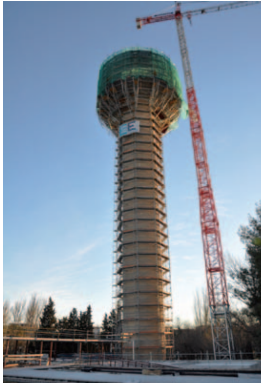
Trabajos de construcción en la torre y depósito superior.
