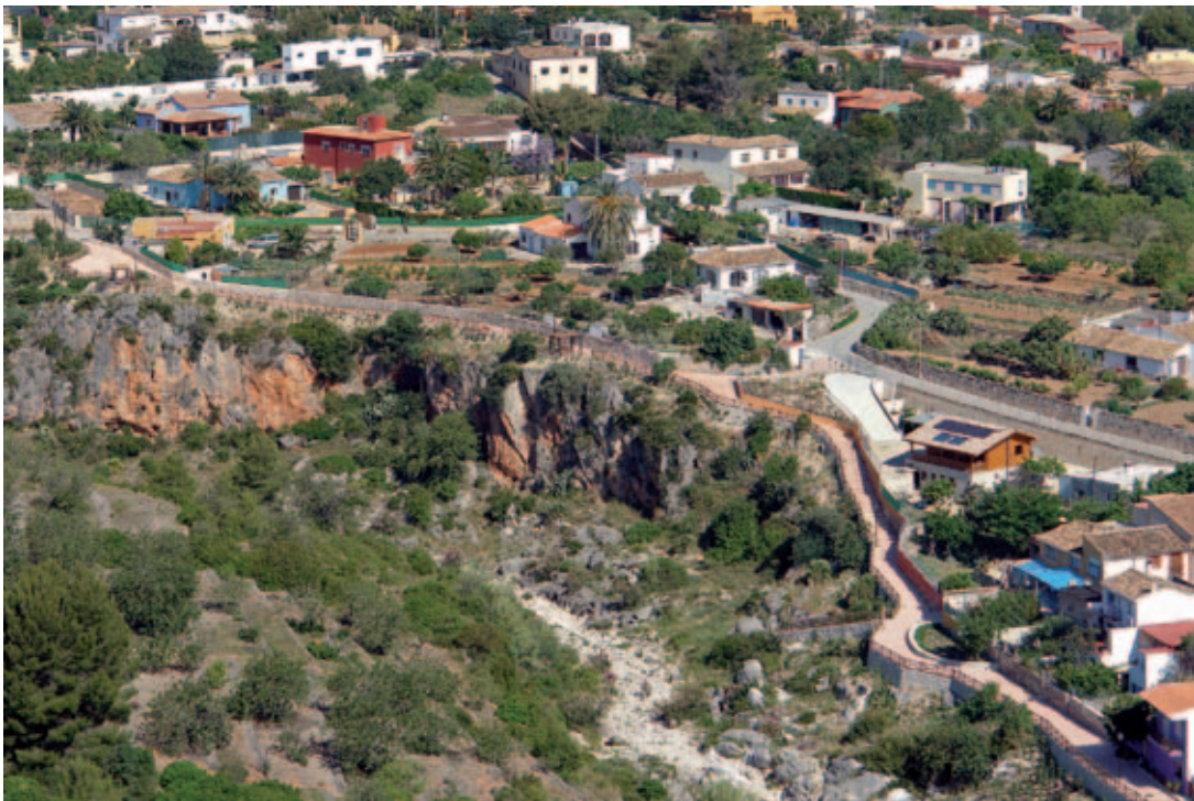
Vista parcial de la actuación.
