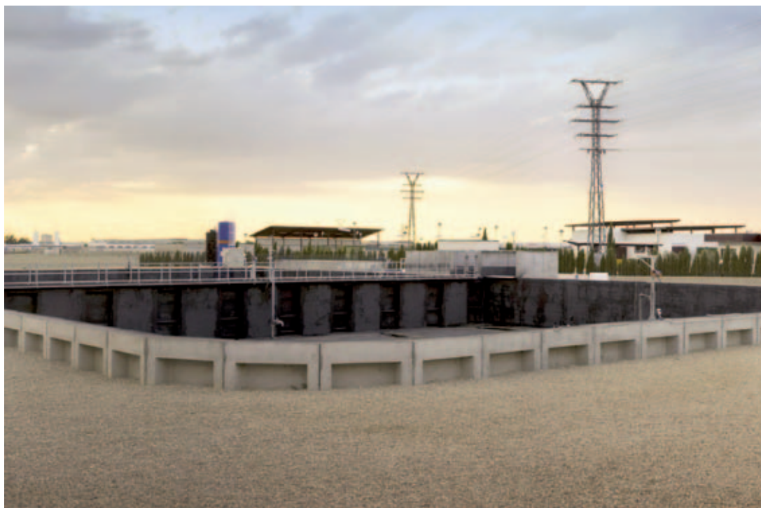
Vista de la depuradora.
