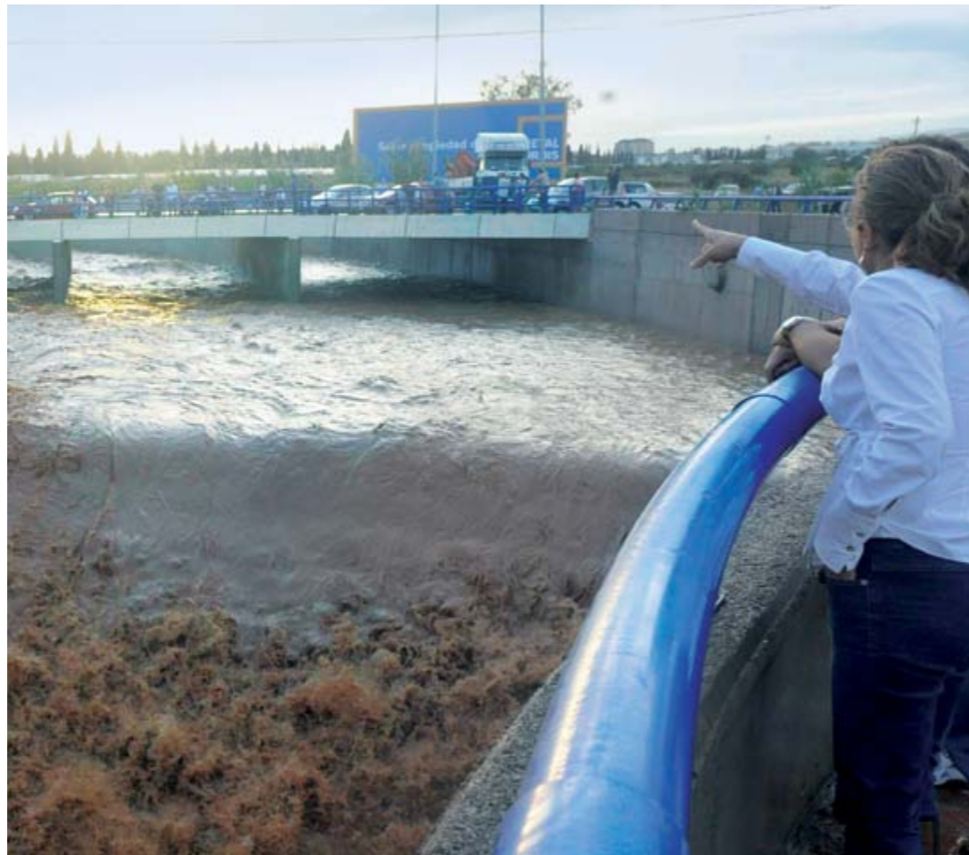
Avenida de agua en el nuevo encauzamiento del río Seco en Castellón
