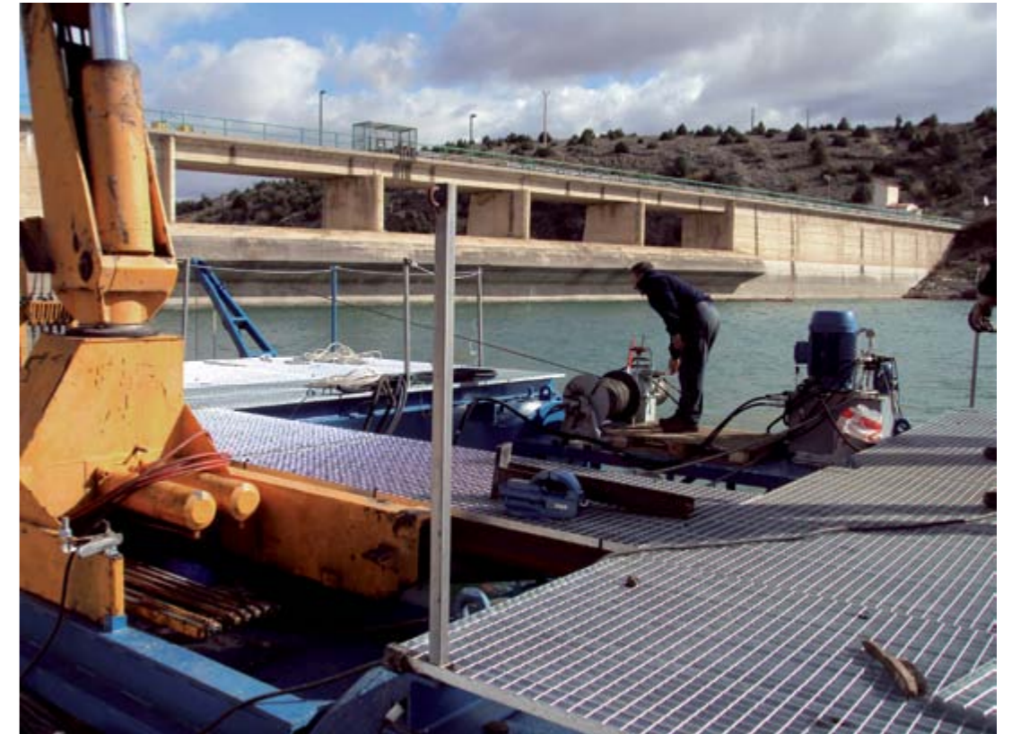
Dragado de lodos y trabajos subacuáticos en el embalse de Arquillo de San Blas (Teruel)
