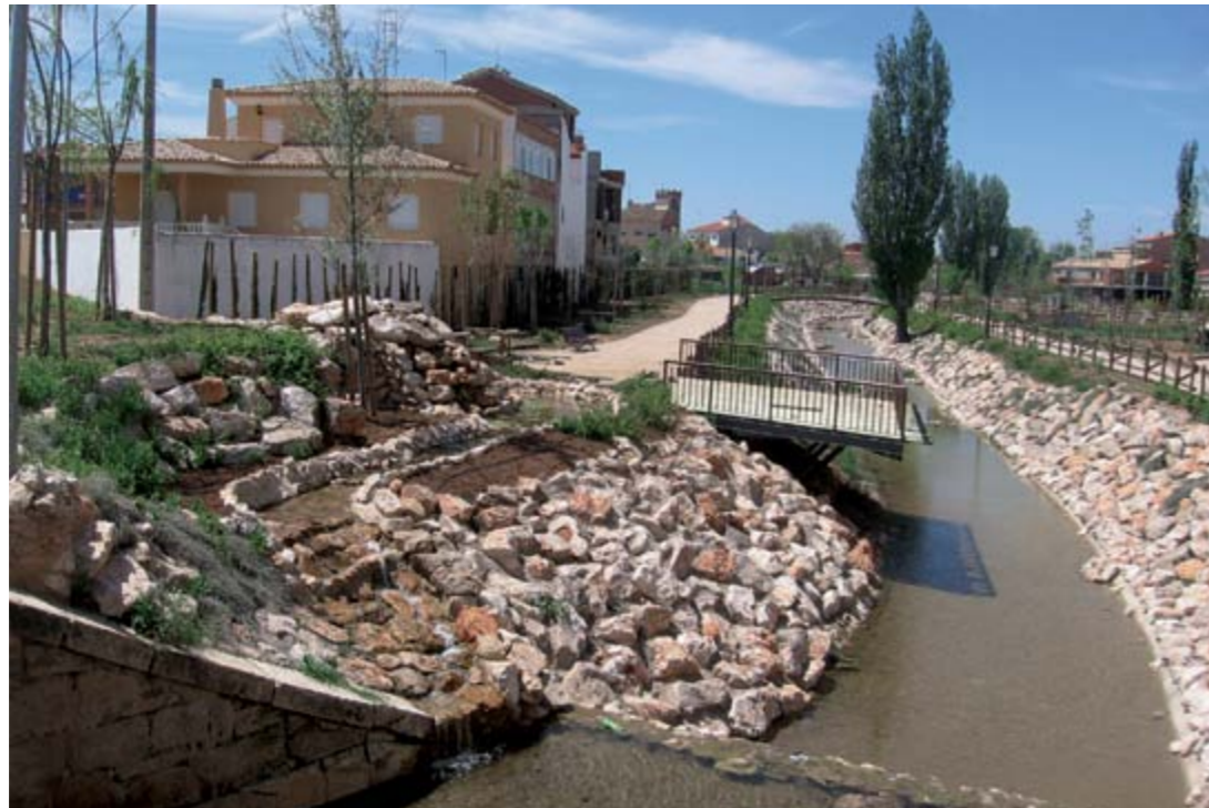
Acondicionamiento del Arroyo de la Cañada en Casasimarro (Cuenca)
