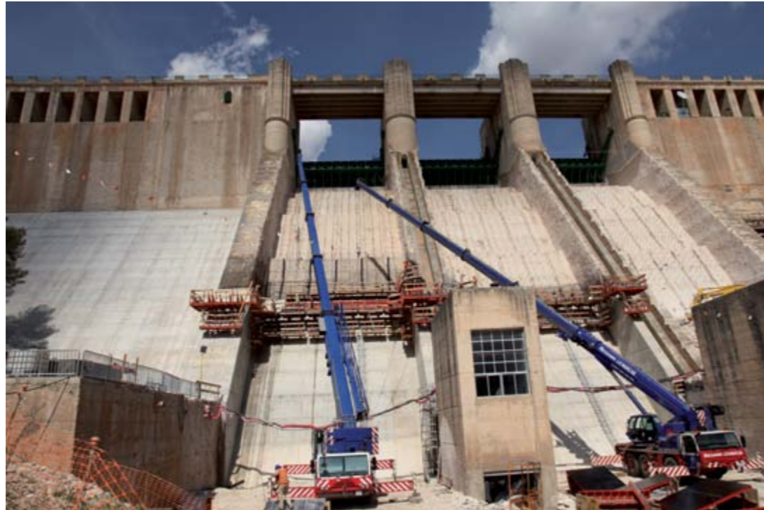
Obras de adecuación del aliviadero de la presa de Alarcón
