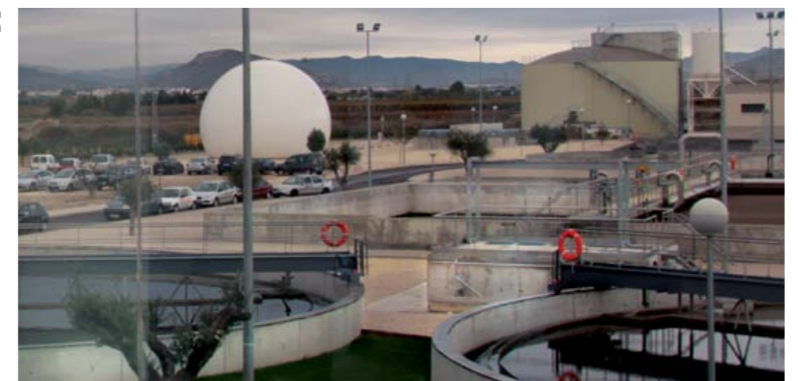
Vista panorámica de la depuradora
