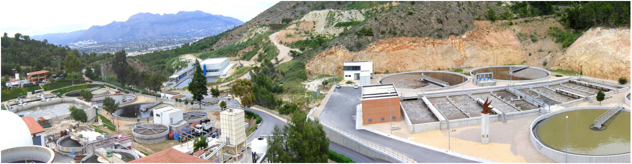
Vista general de la E.D.A.R.
