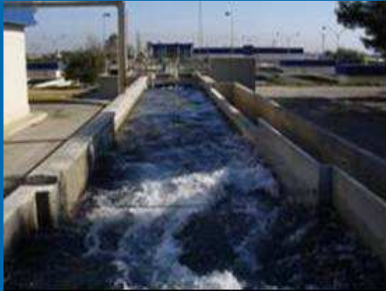
CANAL DE ENTRADA
