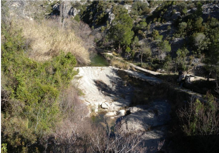
Figura 19. Azud presa del Martinet
