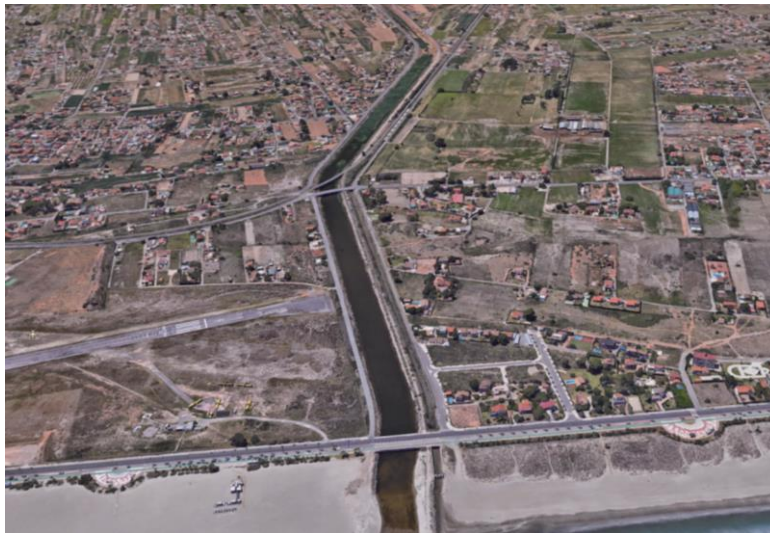
Figura 13. Vista aérea del encauzamiento del río Seco en su desembocadura (Fuente: GoogleEarth)
