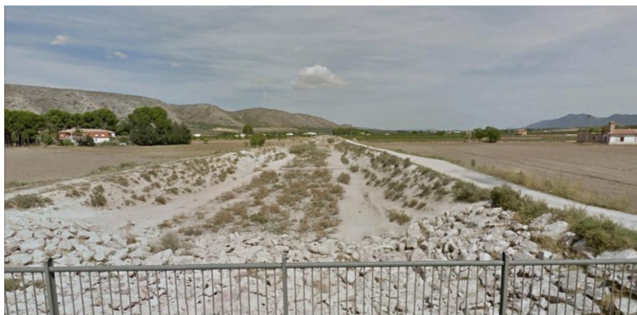
Figura 15. Encauzamiento del río Vinalopó a su paso por Villena (Fuente: GoogleEarth)
