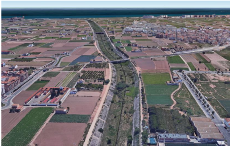
Figura 14. Vista aérea del encauzamiento del barranco de Carraixet a su paso por Almassera (Fuente: GoogleEarth)
