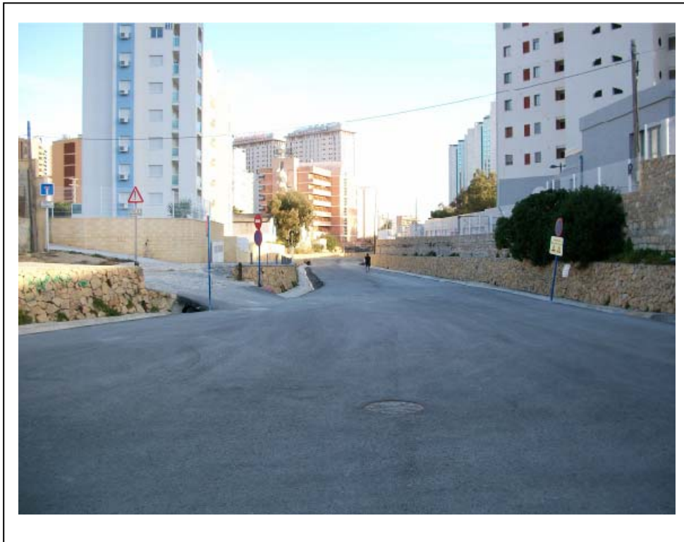
Avenida de Finestrat. Se pueden apreciar los muros de mampostería a ambos lados.
