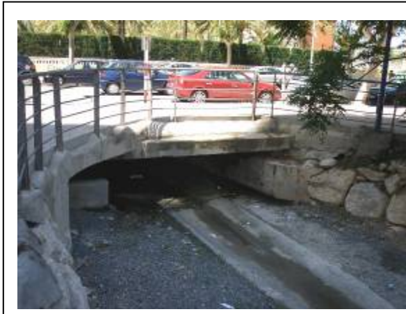
Vista de la embocadura del colector
