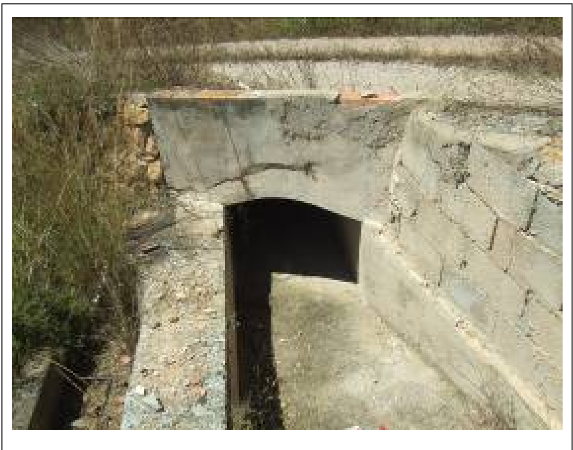
Vista del cruce BEN-107 (badén inundable).camino privado
