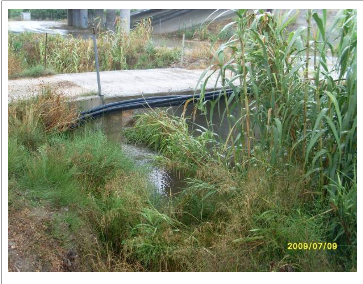
Pontón en camino local aguas debajo de la AP-7. Paso denominado ALT-305
