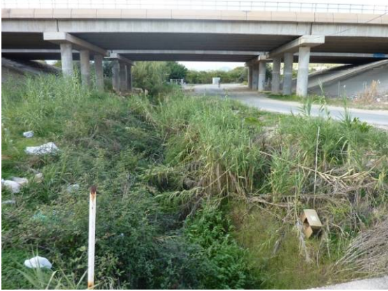
Paso del Barranquet bajo la autopista A-7
