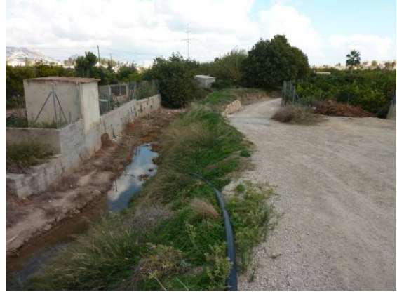
Barranquet, ligeramente encajado a la altura del colegio "El Blanquial". Aquí discurre entre orillas limosas y con un pequeño caudal.
