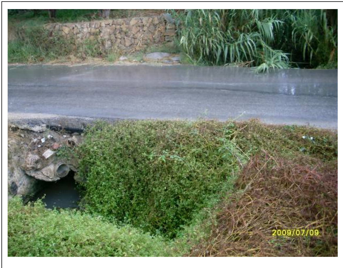
Badén de paso en camino local. (ALT-304)
