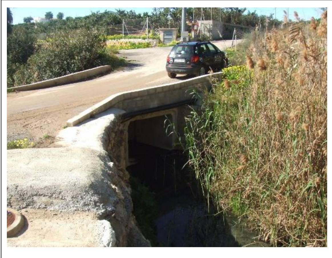
Paso ALT-207. Marco prefabricado en camino local aguas abajo de la AP-7
