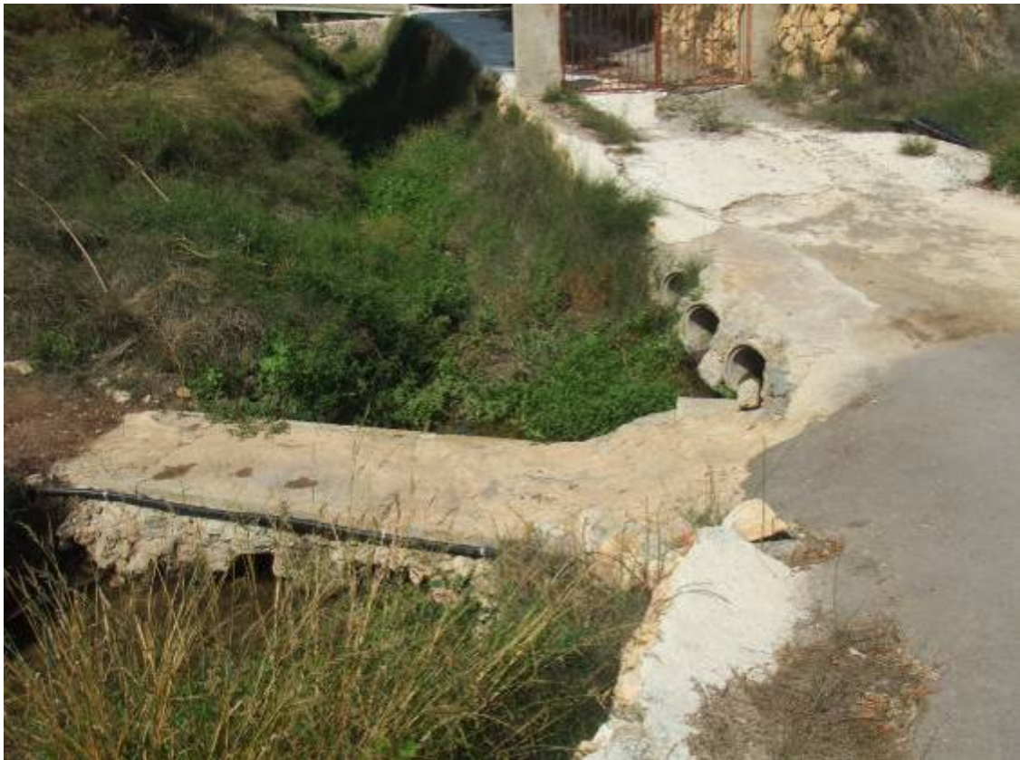
Paso ALT-206. Badén inundable en camino privado
