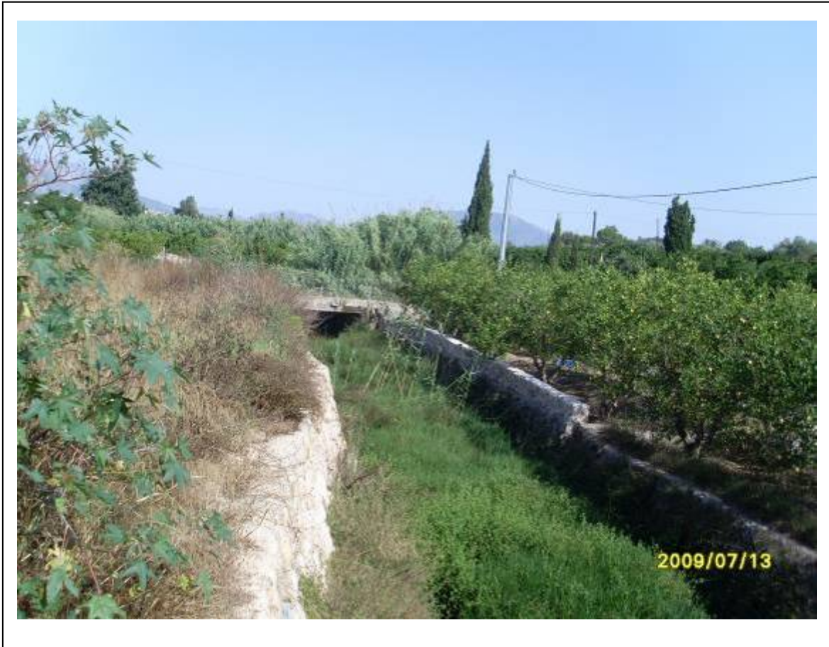
Paso ALT-205. Pontón en camino local
